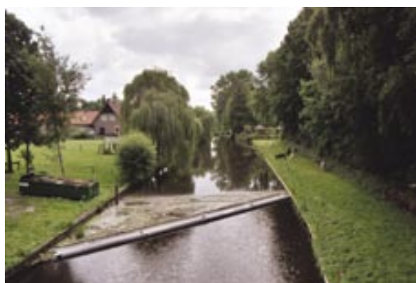
Grift/Valleikanaal: harde oeverinrichting
