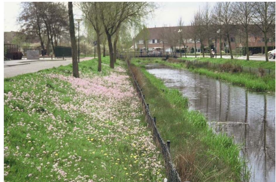
Voor de veiligheid is een hekwerk langs de oever geplaatst
