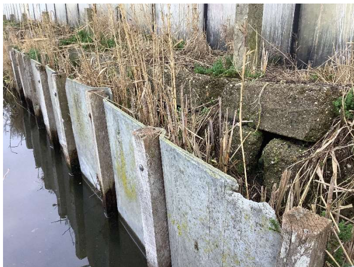
foto 6: beschoeiing watergang deellocatie 1 - houten palen met GVC-platen en betonbrokken
