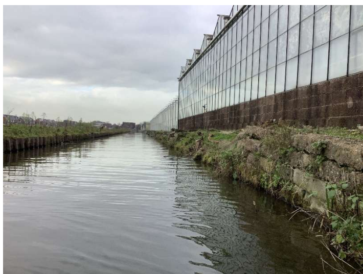
foto 7: betonbrokken beschoeiing (gestapelde kasfundering) deellocatie 1, welke doorloopt tot deellocatie 3
