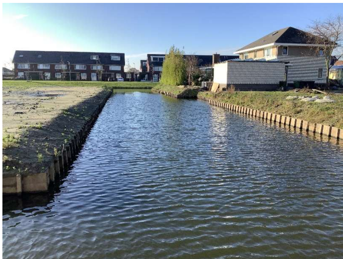
foto 1: houten beschoeiing watergang > 70 m afstand van deellocatie 1
