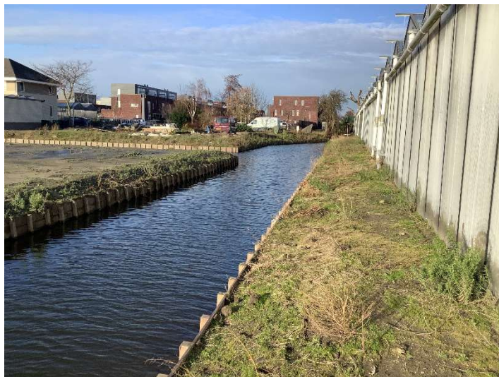
foto 2: houten beschoeiing watergang deellocatie 1
