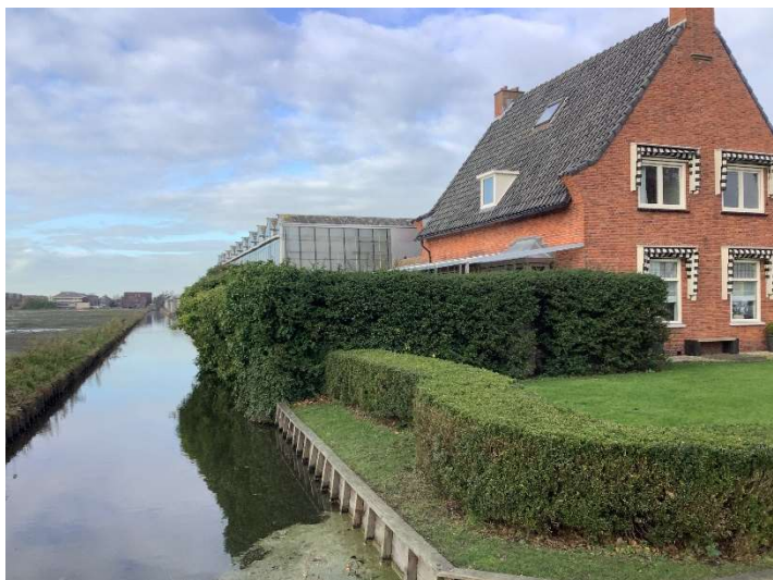
foto 9: watergang nieuwe houten beschoeiing deellocatie 3 nabij siertuin woning met huisnummer 87
