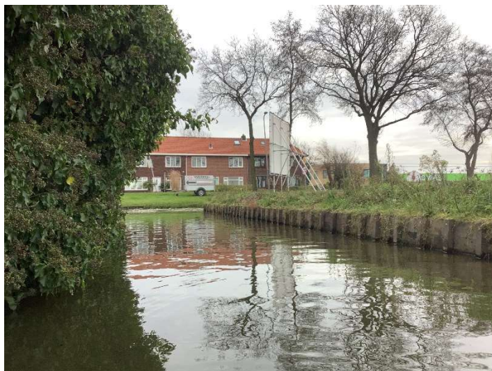
foto 10: watergang deellocatie 3 (Middel Broekweg)
