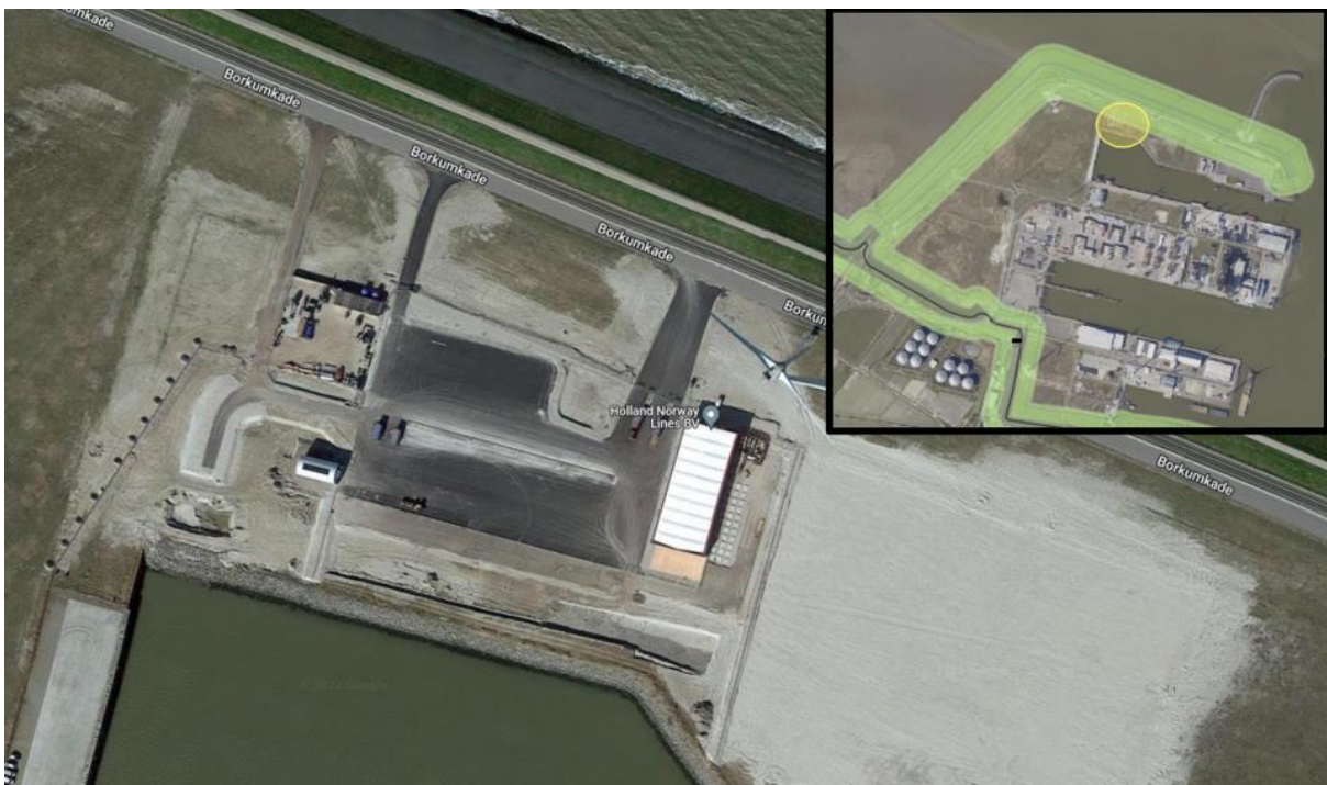
Figuur 1: De locatie van werkzaamheden nabij de Borkumkade in de Eemshaven (zie kader)
