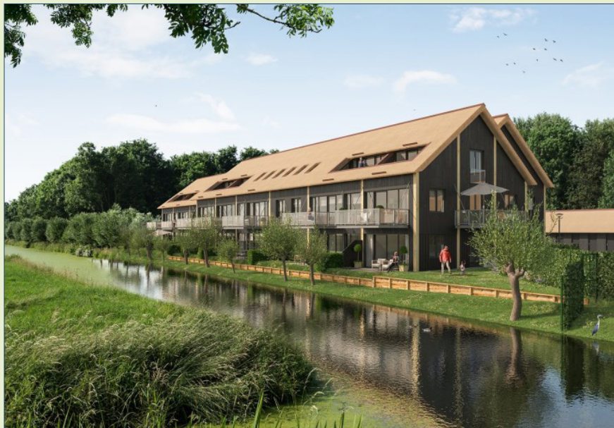
Zorgappartementen in een 'loods'; van twee lagen met kap
