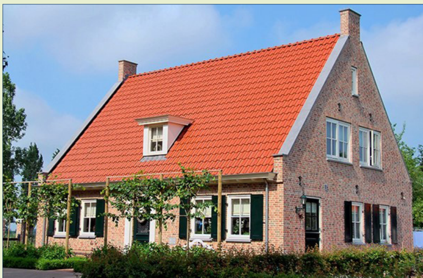
C1) 1 laag met zadeldak, lage goot en veel details in de gevel, zoals luiken en metselwerk
