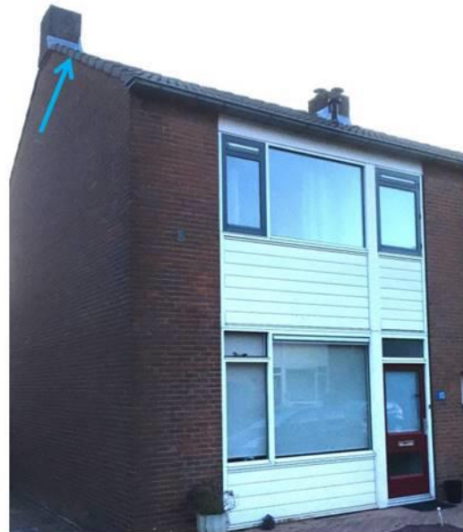
Gendt, 07 juli ochtend 2021 – Kraamkolonie Gewone dwergvleermuis (>20 zwermende, gevel-aantikkende en invliegende individuen), zijgevel Van der Duyn van Maasdamstraat nr. 10 onder de bovenste 3 dakpannen vanaf schoorsteen aan de voorzijde (blauwe pijl).
