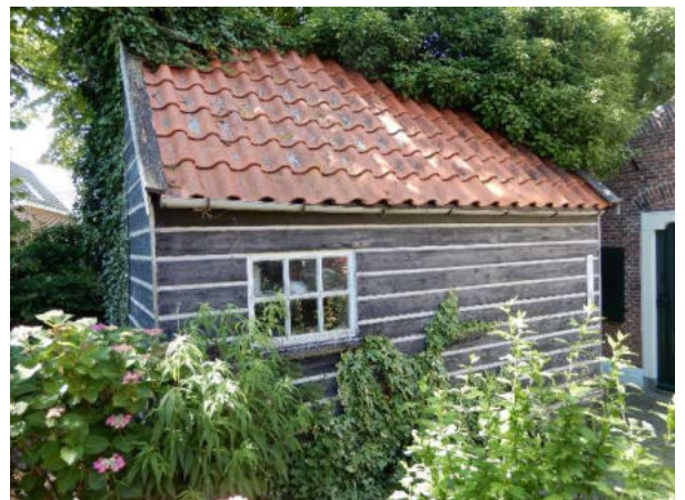
Te slopen houten schuur
