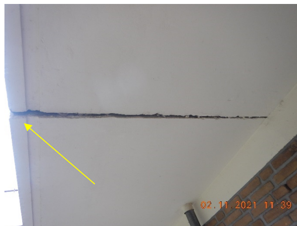
Figuur 3.4: Galerijvloeren buigen door ten opzichte van ingeklemde galerijvloeren bij trappenhuis.
