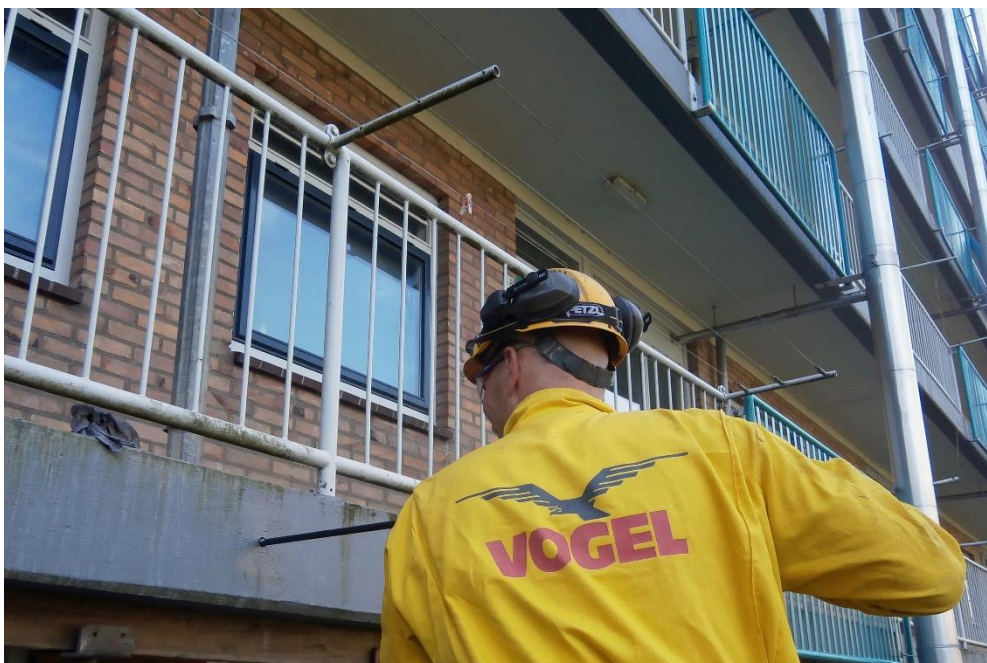
Foto 2: boorgat tijdens aanbrengen anker
