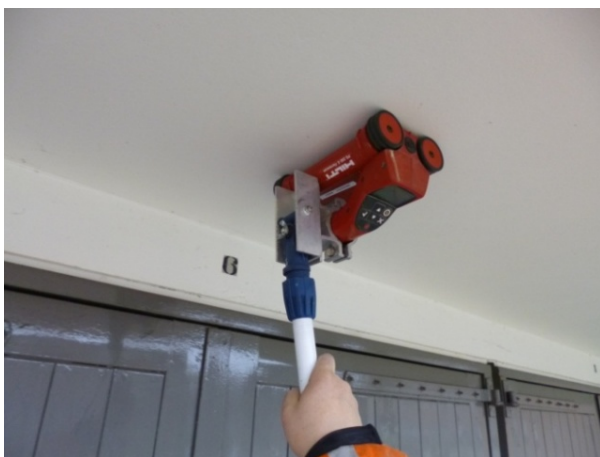
Figuur 5.3: Lijnscan(dekkings)meting Ferroskan aan de onderzijde van een galerijvloer.
