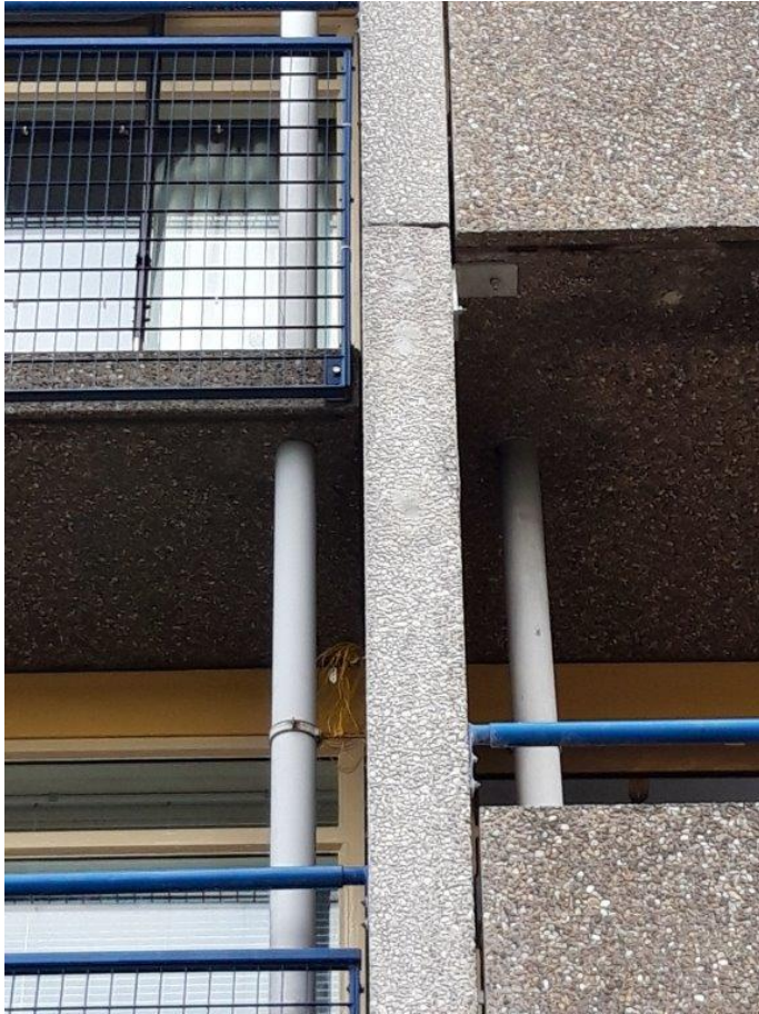
Foto 3: boorgaten afgewerkt na aanbrengen anker en verlijmen
