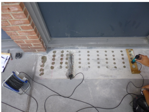
Figuur 5.9: Uitvoeren van een potentiaalmeting.
