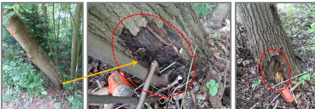
Fig. 1: De boom staat zeer scheef en helt over het fietspad langs de Oegstgeesterweg. In de stamvoet en wortelkluif van de boom is houtrot ontstaan waardoor het risico op windworp toeneemt.
