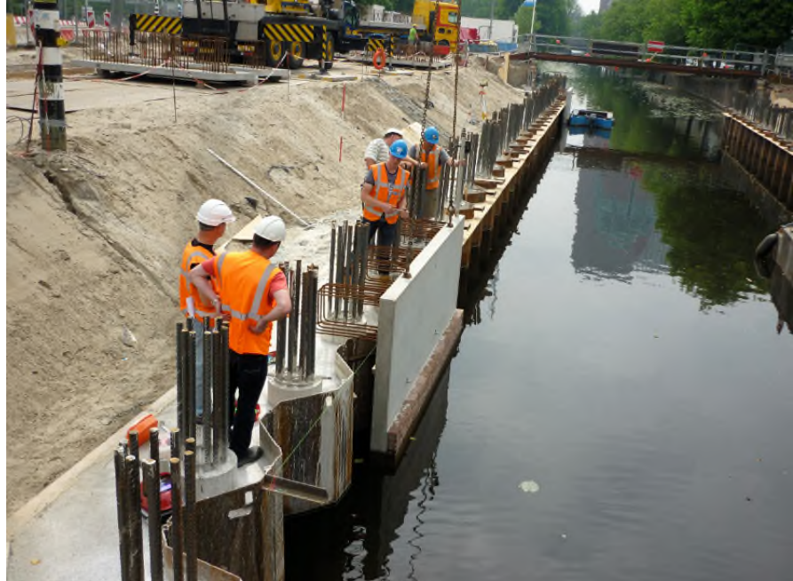
Figuur 13 | voorbeeld schort aan damwand
