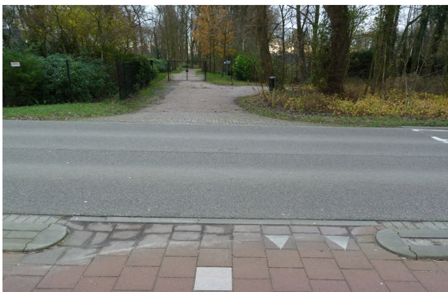
Foto 4 | aansluiting tennisbanen / Nieuw Vredenoord
