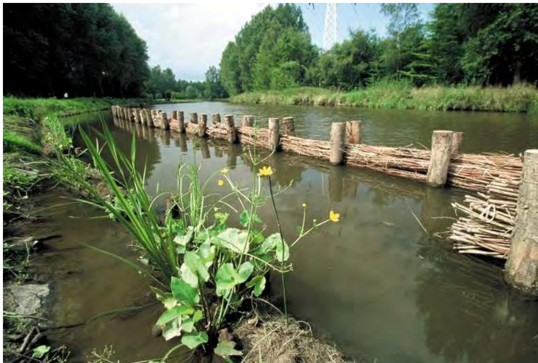
Figuur 3.2 Voorbeeld van een vooroever van wilgentenen (bron: Instituut voor Natuur- en Bosonderzoek)
