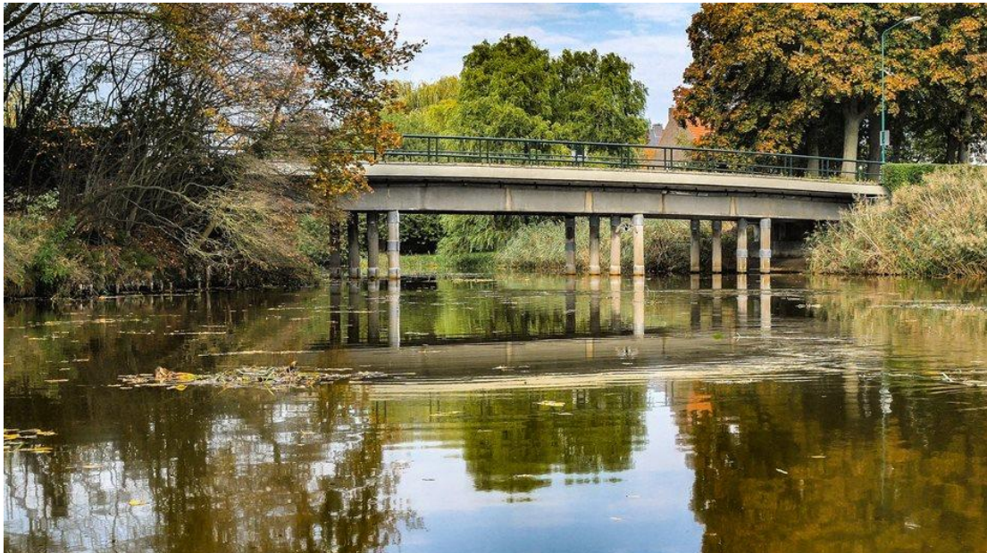
Figuur 2.2 Graafsche Raam ter hoogte van de Henri Dunantsingel
