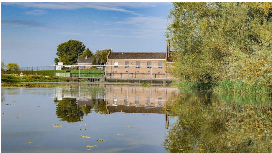
Figuur 2.4 Graafsche Raam ter hoogte van Gemaal van Sasse
