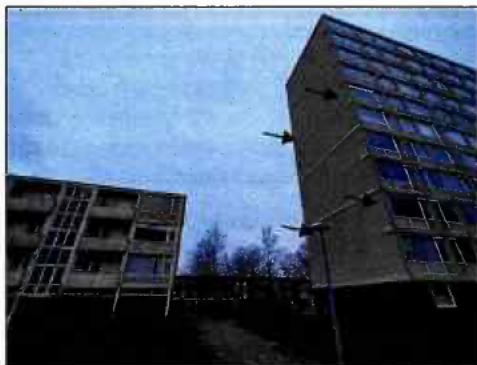
Afbeelding 8: Locaties permanente voorzieningen zuidgevel
