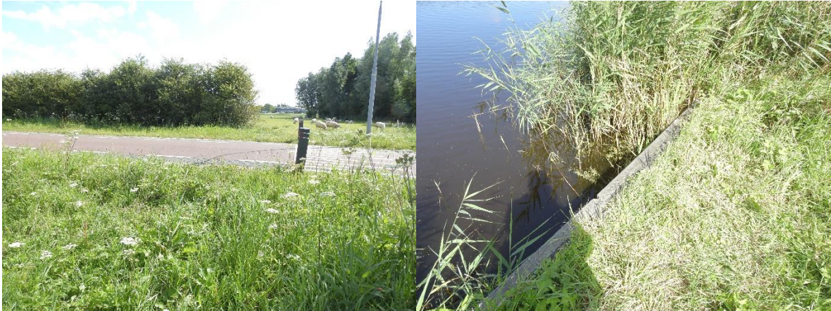
Figuur 2.8 Locatie ten noorden van Uitgeest waar een duiker wordt geplaatst.
