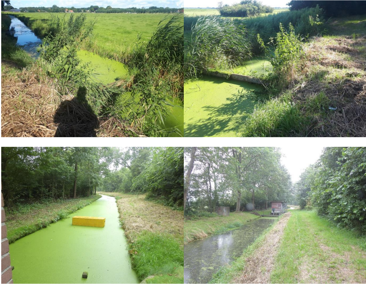
Figuur 2.2 De locaties ten noorden van Bakkum/Castricum waar een klepstuw (bovenste foto's) en een stuw (onderste foto's) worden geplaatst.
