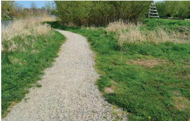
Smalle wandelpaden van halfverharding
