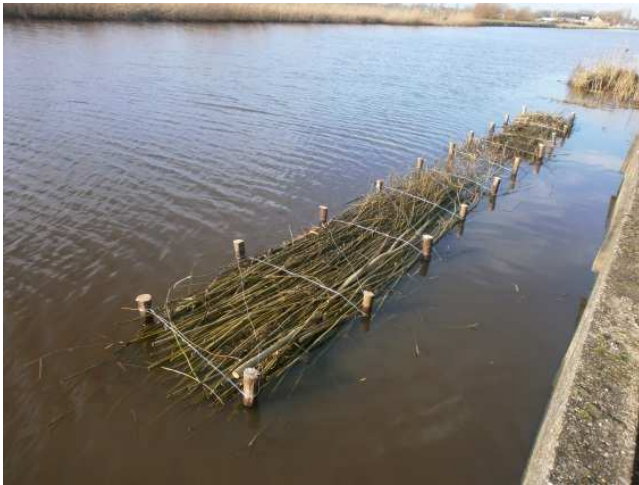
Figuur 4.5 Voorbeeld van takkenstructuren vastgelegd met palen en ijzerdraad
