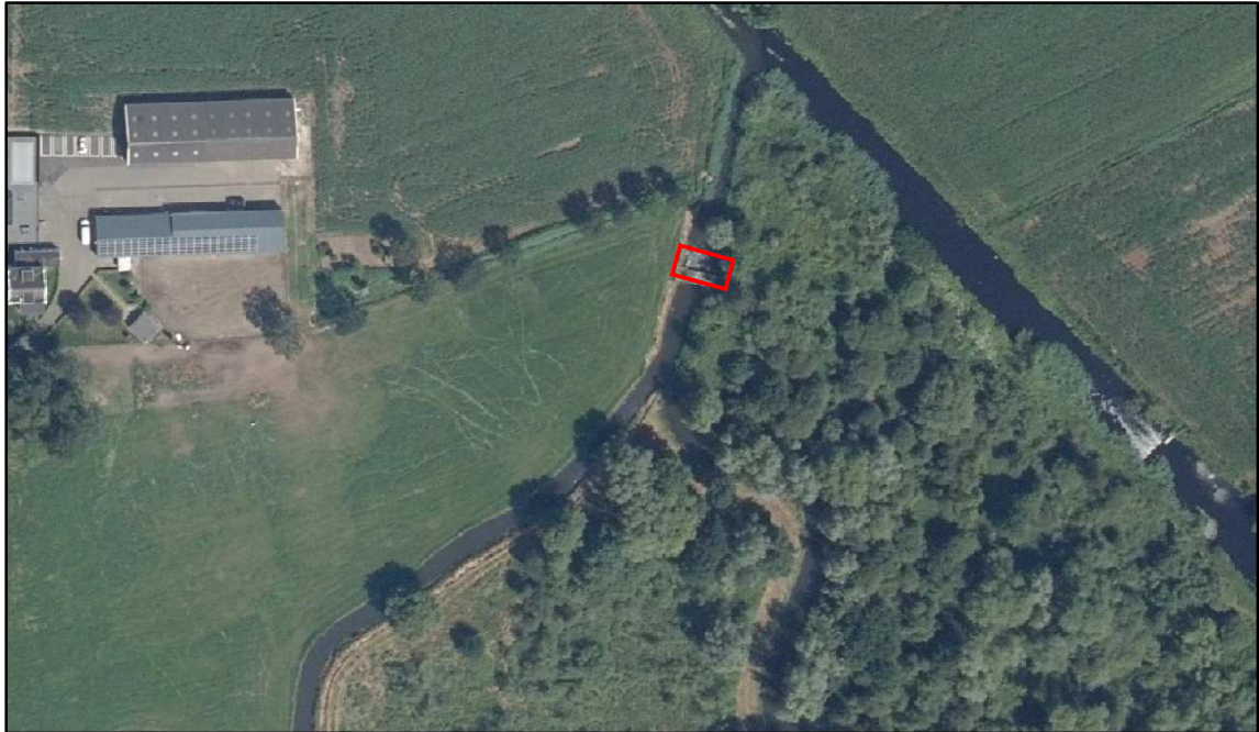
Figuur 2.2 Luchtfoto van de situatie; in het rode kader ligt de stuw in de Gulden Aa
