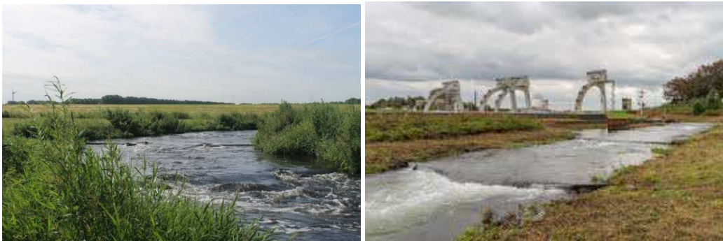
Figuur 3.6. Voorbeelden van vispassages opgebouwd met v-vormige overlaten. Links: vispassage Crevequeur Q=3,5 \text{ m}^3/\text{s} . Rechts: vispassage Hagestein Q = 4,0 \text{ m}^3/\text{s} .
