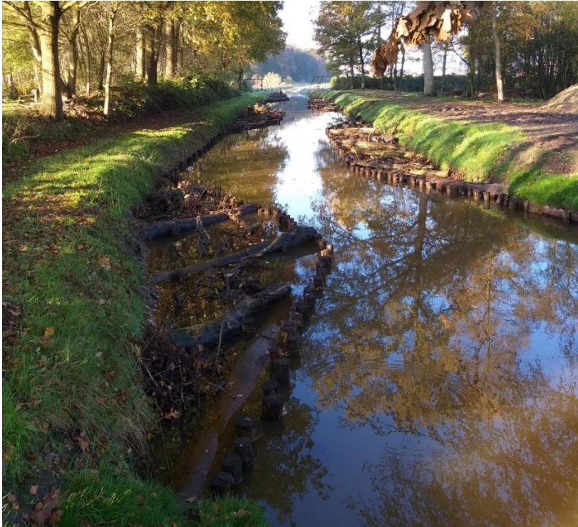
Figuur 13: Doodhoutpakketten in watergang
