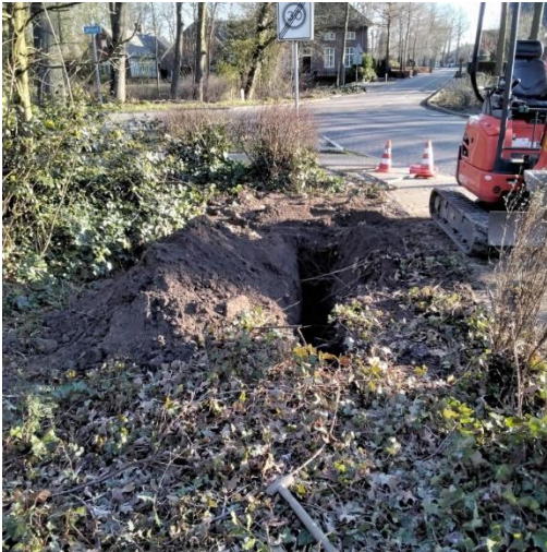
Figuur 3: Proefsleuf t.b.v. vrije ruimte voor INCO-container
