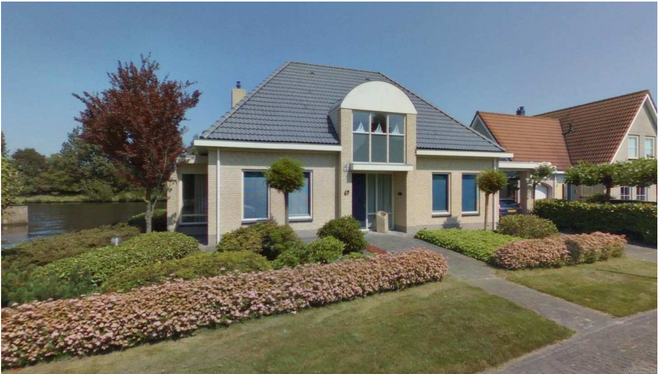
Referentiebeeld 1 - dakopbouw door geveloptrekking grenzend aan voorerfgebied
