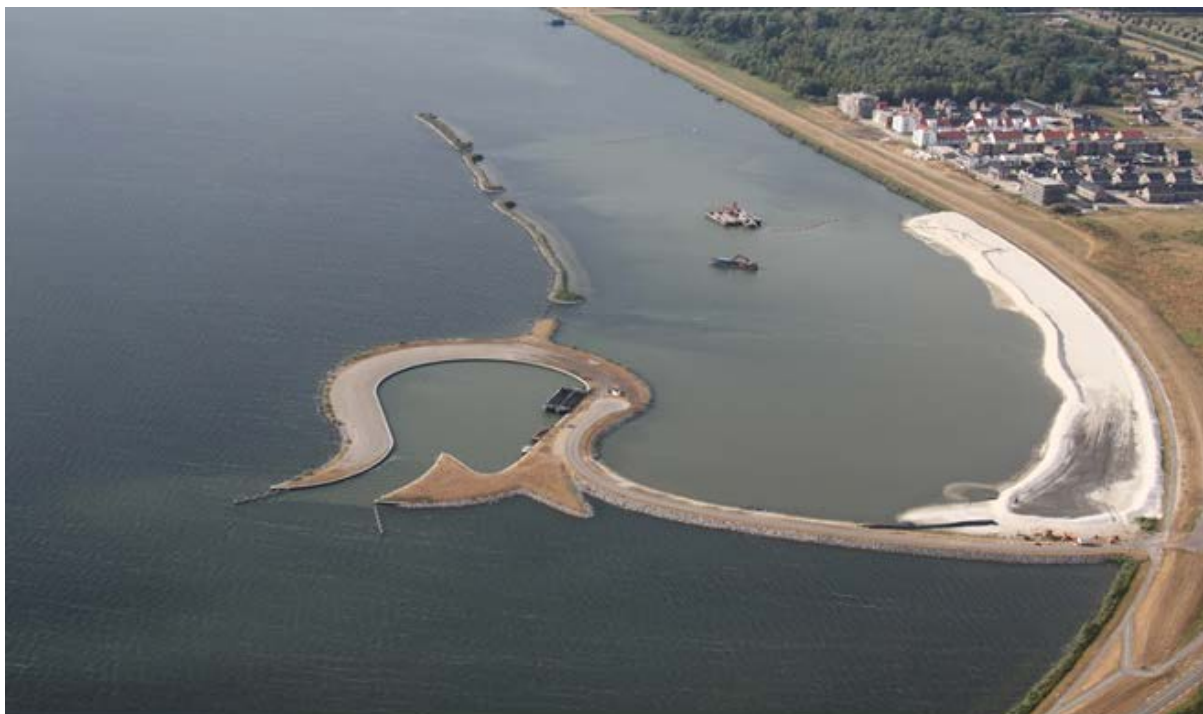
Figuur 2 Lanterstrand in aanleg bij Tulpeiland
