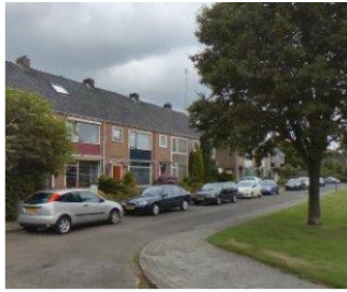
C Perrongebouw met kap welstandsniveau 1 (gemeentelijk monument)
