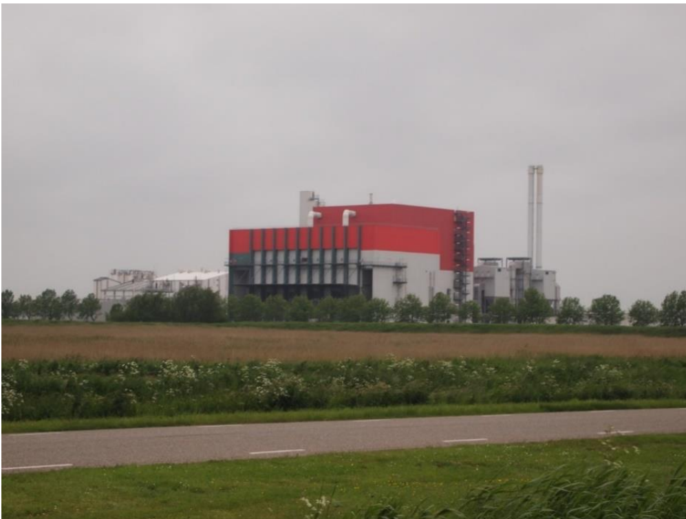
Afbeelding 1 Noordoostaanzicht van de installatie van EEW ten tijde van de aanvraag van de derde lijn. Dit aanzicht kijkt op de bunker, met daarachter de eerste twee lijnen (afvalverbranding, rookgasreiniging en schoorsteen) (Bron: foto uit eigen bestand)
