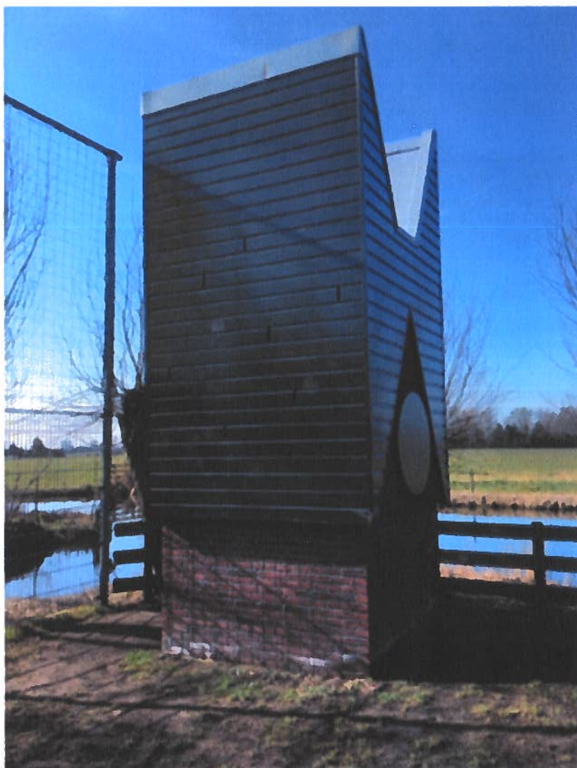
Figuur 4: De geplaatste vleermuistoren ter compensatie.
