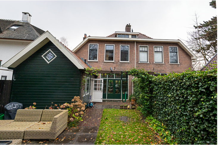
afbeelding 2: achtergevel Nassaulaan nr. 5 (link) en nr. 3 (rechts)
