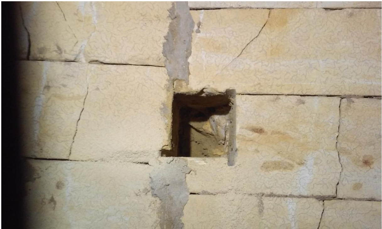
Locatie 4, de grond duidelijk waarneembaar boven het testgat in het gewelf
