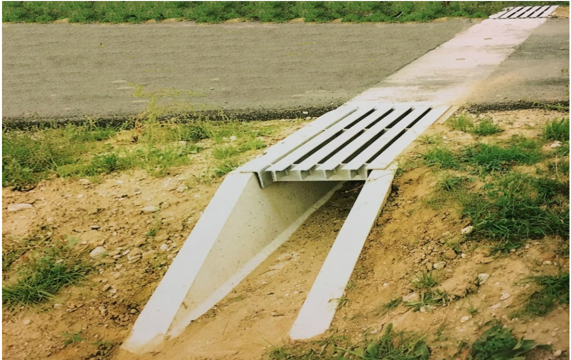
Figuur 5: Beeld van dassentunnel onder de Oude Zutphenseweg, die aangelegd wordt met het oog op de betere bereikbaarheid van westelijk foerageergebied.
