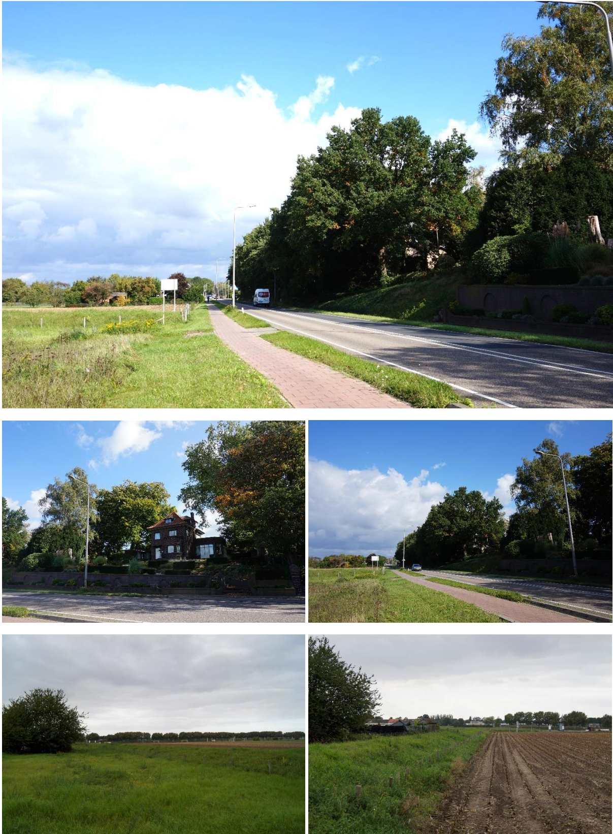
Figuur 16 (van links naar rechts): a-b-c: Steilrand bij Rijksweg-Noord, d: Rijksweg Noord, e-f: Polder bij Rijksweg-Noord die door het nieuwe dijktracé zal worden doorsneden.
