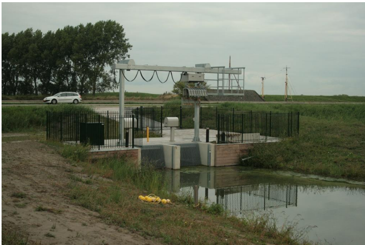
Figuur 1: Instroomzijde parallelle sifons onder het havenkanaal van Middelharnis.
