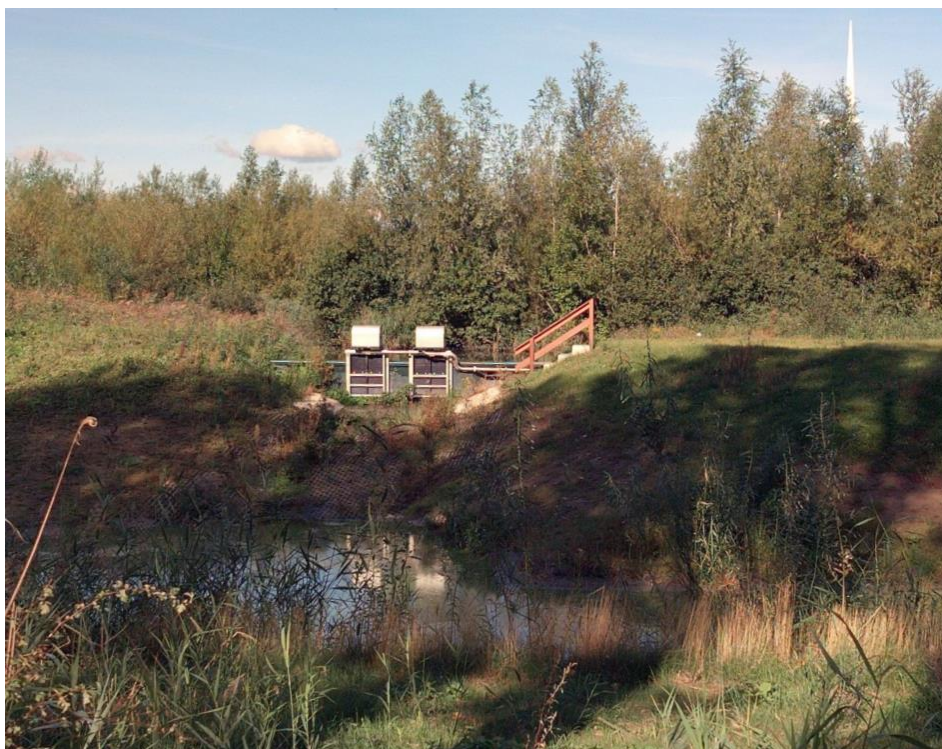
Figuur 9: Calamiteitenstuw Inlaat van Pallandt.
