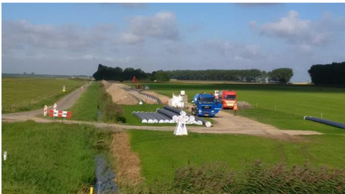
Figuur 7: Aanleg Evides infiltratieleiding nabij de sifons van Middelharnis (bron: www.evides.nl )
