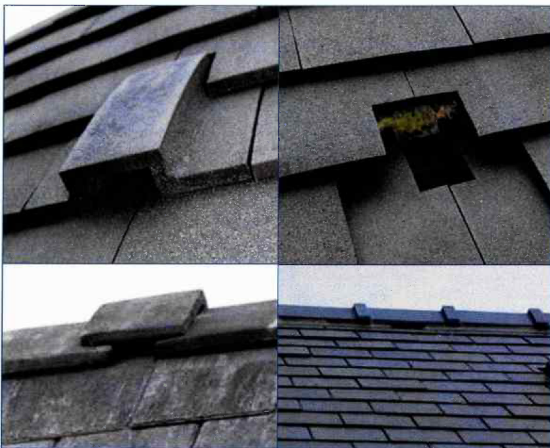
Figuur 3 Verschillende voorbeelden waarbij zadeldakdelen geschikt gemaakt zijn voor vleermuizen.
