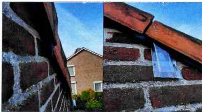
Figuur 4: Toepassing van eerder project waar rondschuim onder kantpannen toegepast is met op verschillende plaatsen exclusion flaps.
