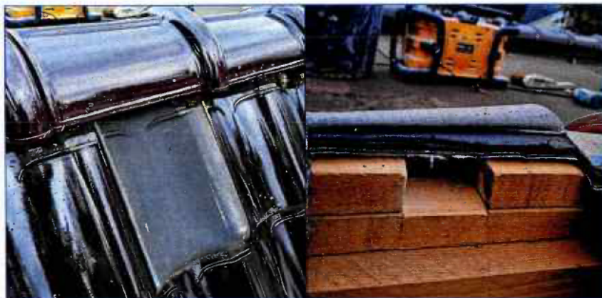
Figuur 1: Weergave van het geschikt maken van het bijgebouw. De nokken zijn op diverse plaatsen open gesteld door openingen te realiseren in het houtskelet. Toegang is gewaarborgd door de plaatsing van gebakken (ongeglazuurde) dakpannen voor het vastgrijpen.
