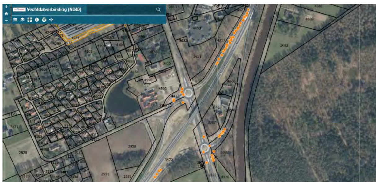
Figuur 14: Gekapte bomen voor het maken van een nieuwe aansluiting bij de Balkerveg
