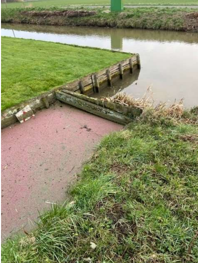
Afbeelding 8: Vaste dam KVD-566
