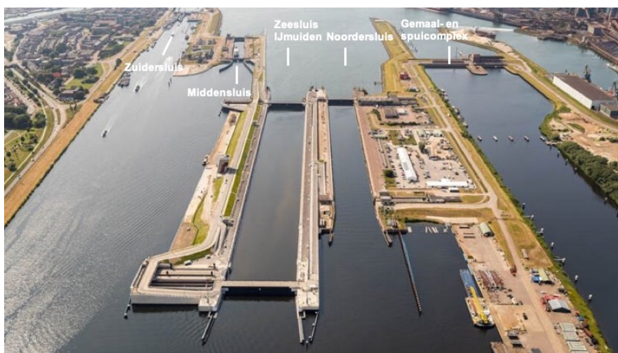
Figuur 2.2 weergave van de verschillende sluisen in IJmuiden. De Zeesluis IJmuiden is twee keer zo groot als de Noordersluis. (bron: Rijkswaterstaat)
