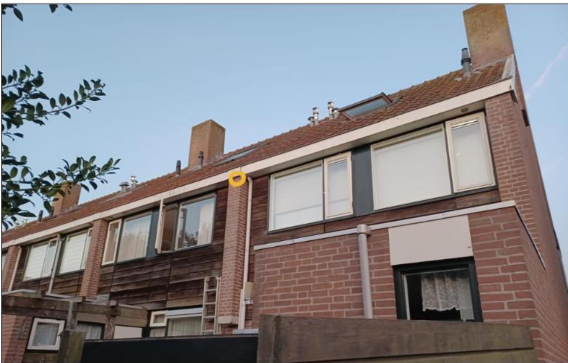
Figuur 4: Locatie oorspronkelijke van de gewone dwergvleermuis verblijfplaats aan de achtergevel van de Kerklaan 23 – 25 welke in de uiteindelijke situatie weer functioneel zal zijn.
