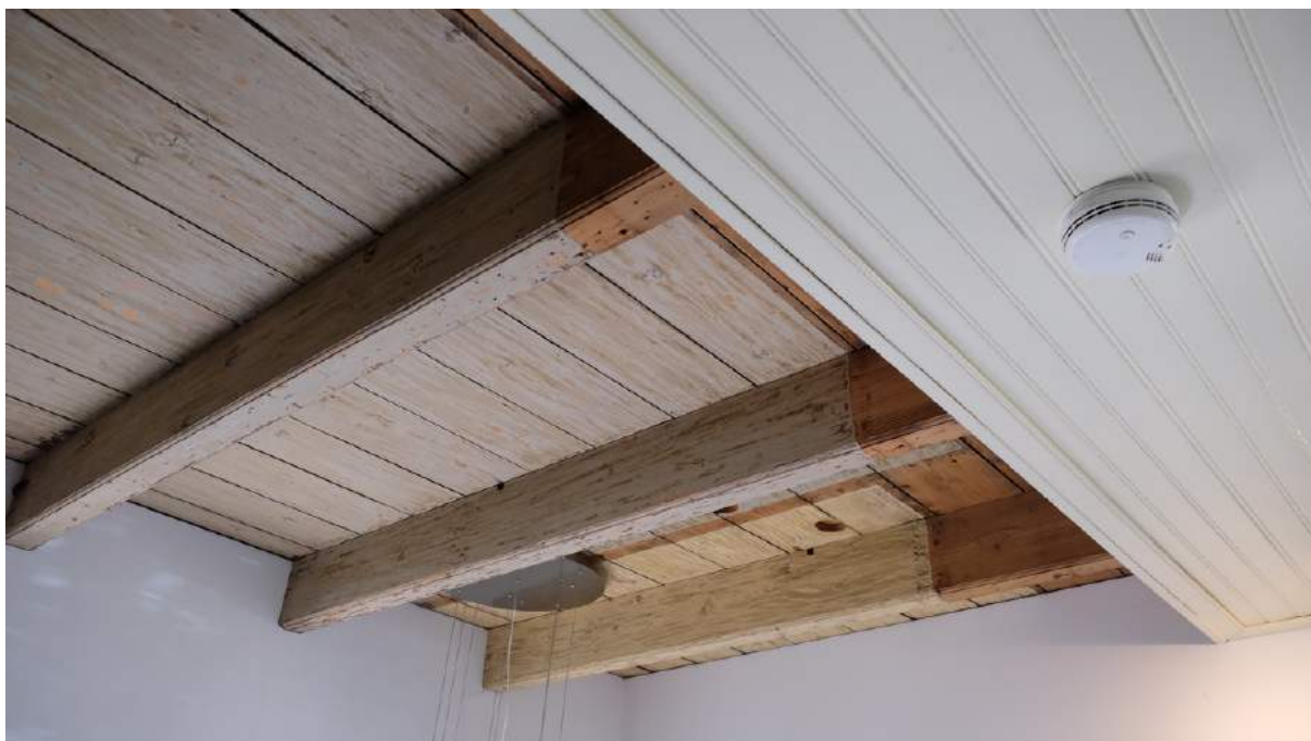
Plafond kamer polderkruinniveau (rechts van de gang) met in het plafond herkenbare historische indeling en plankenplafond met dubbele kraal.
