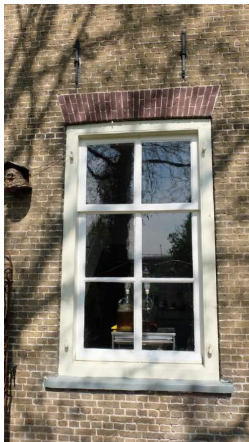
Links: Achterdeur met levensboom in het bovenlicht. Rechts: kozijn met zesruits schuifraam rechts van de achterdeur.
