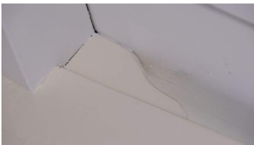
Sierlijk gesneden blokjes tussen gebogen spant en het dakbeschot.
