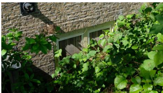
Rechts: Zijgevel links (noordwestzijde) met een kozijn met zesruits schuifraam, rozetankers en geheel links in de gevel de nieuwe muurankers. Rechts: het kelderraam in de linkerzijgevel.
