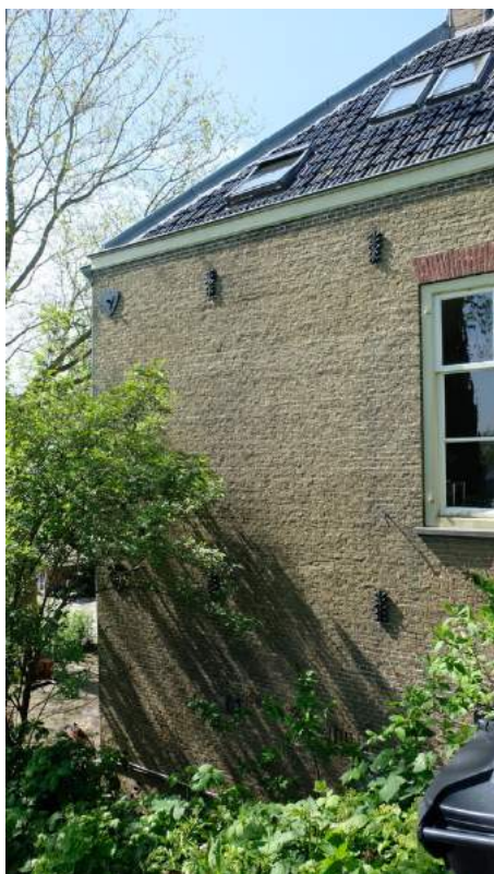
Rechts: Zijgevel links (noordwestzijde) met een kozijn met zesruits schuifraam, rozetankers en geheel links in de gevel de nieuwe muurankers. Rechts: het kelderraam in de linkerzijgevel.
