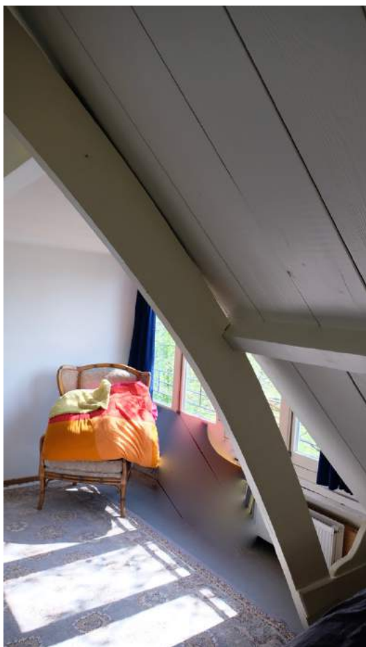
Links: gebogen spant van het Philibertspant. Links: Makelaar van het Philibertspant.
