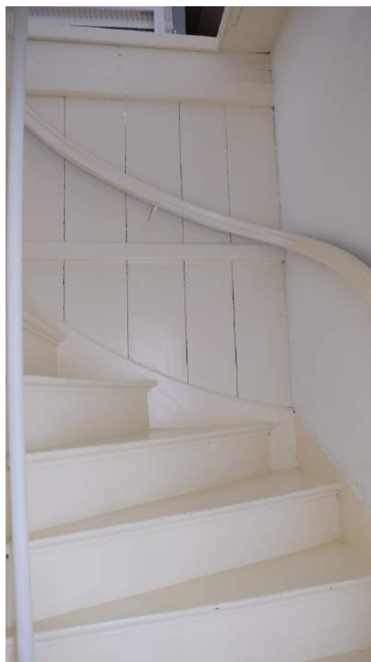
Links: oorspronkelijke deur met deurwervel. Rechts: trapopgang naar de zolder met oorspronkelijke handlijst, draagbeugels en wandbetimmering.
