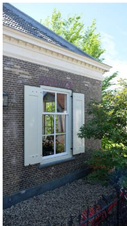
Rechts: de voordeur voorzien van omlijsting en kroonlijst. Links: Het kozijn met schuifraam rechts van de voordeur.
