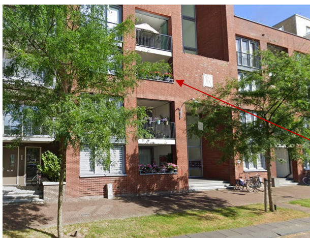
Locatie balkon in het pand
