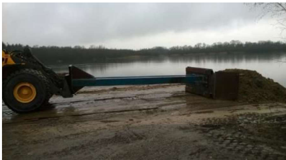
Afbeelding 6.4 Shovel met verlengde giek
