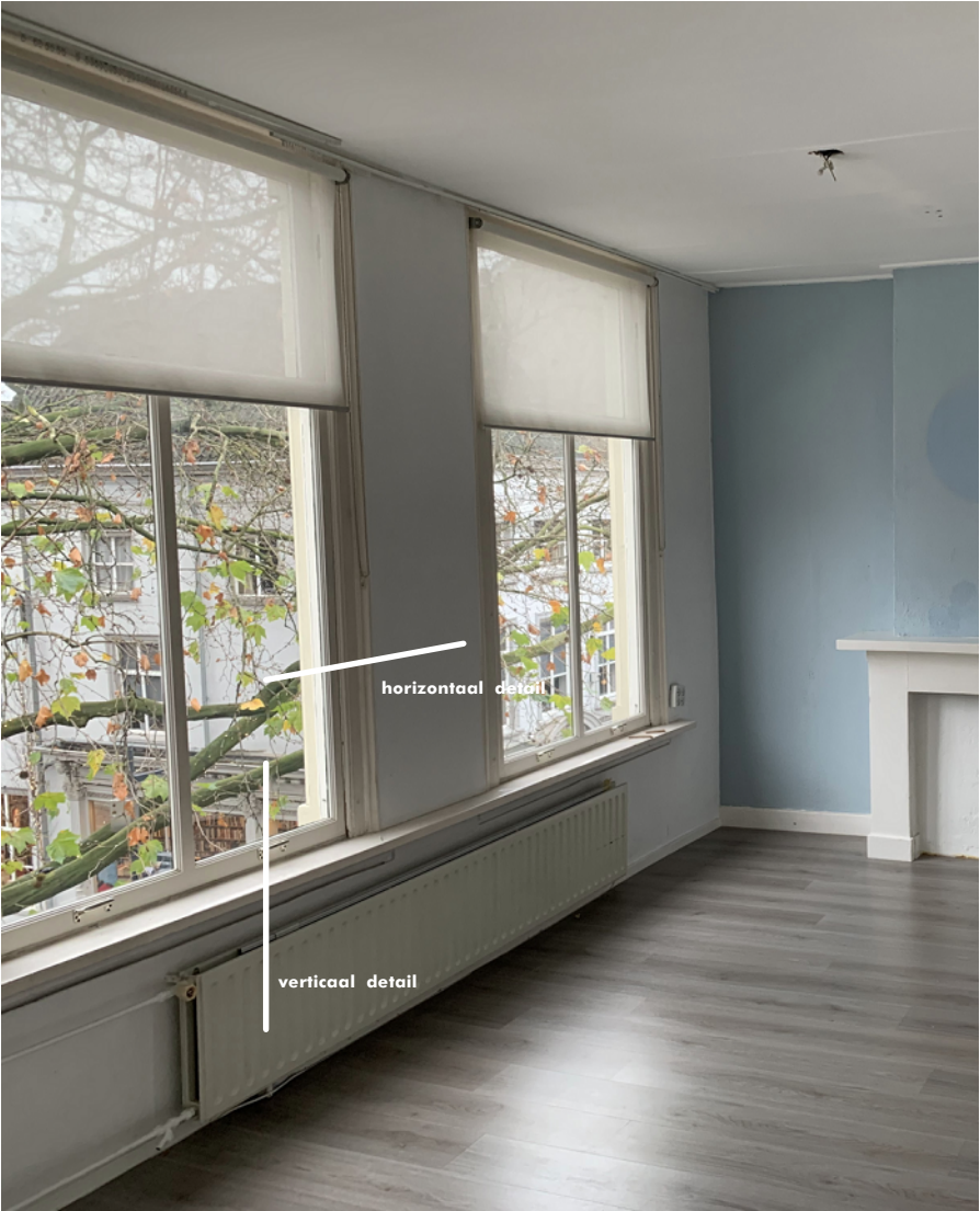
foto ramen voorgevel / bestaande toestand
