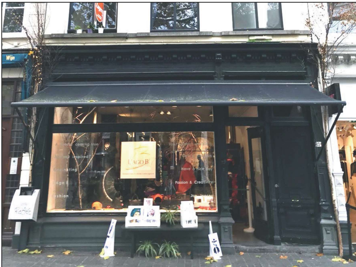
Afb. 13: De onderpui anno 2020.
