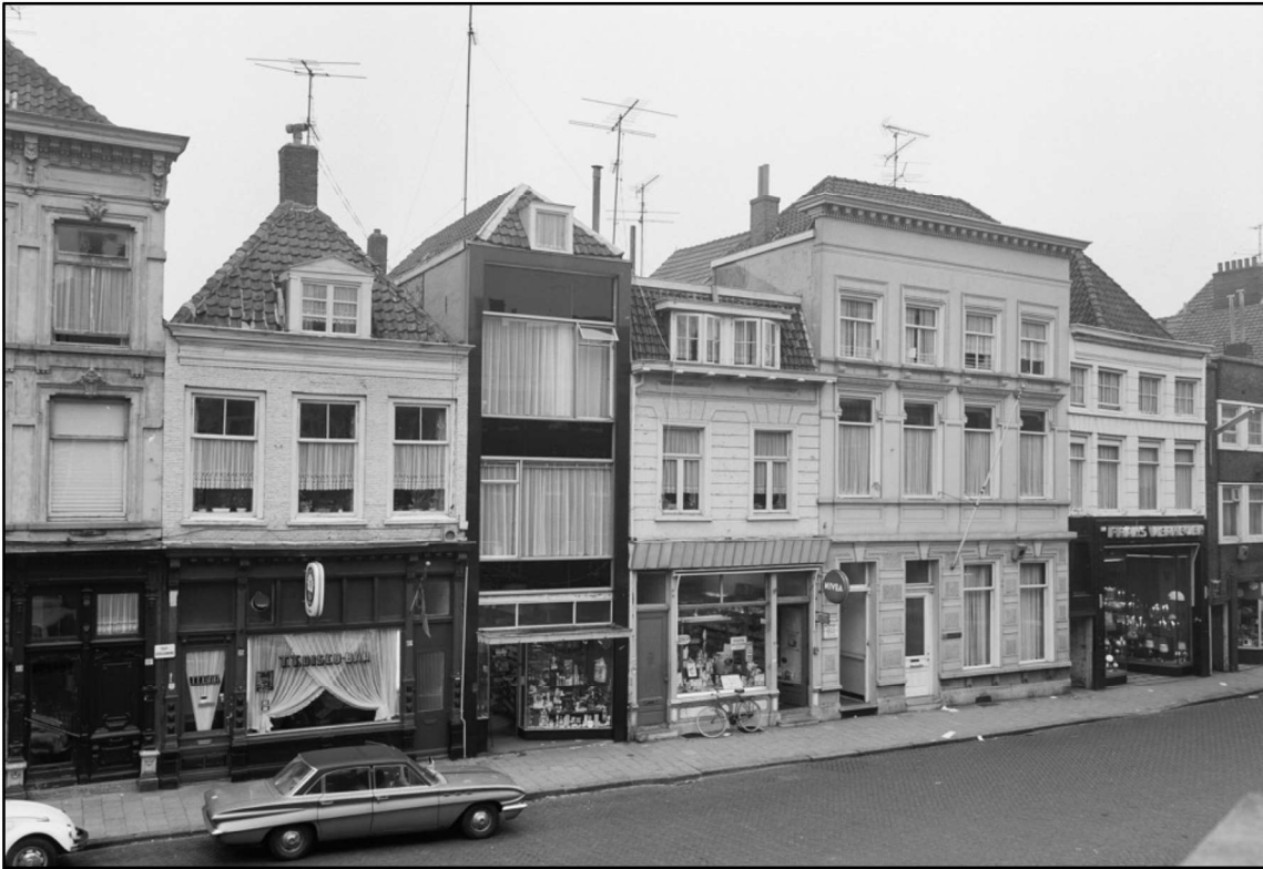
Afb. 10 A: Uiterst links de voorgevel in 1970. Intussen is het pleisterwerk wat gehavend en verschenen er nieuwe ramen op de eerste verdieping, zonder middenstijltje. [RCE, Tangel / bijgesneden door de auteur]
