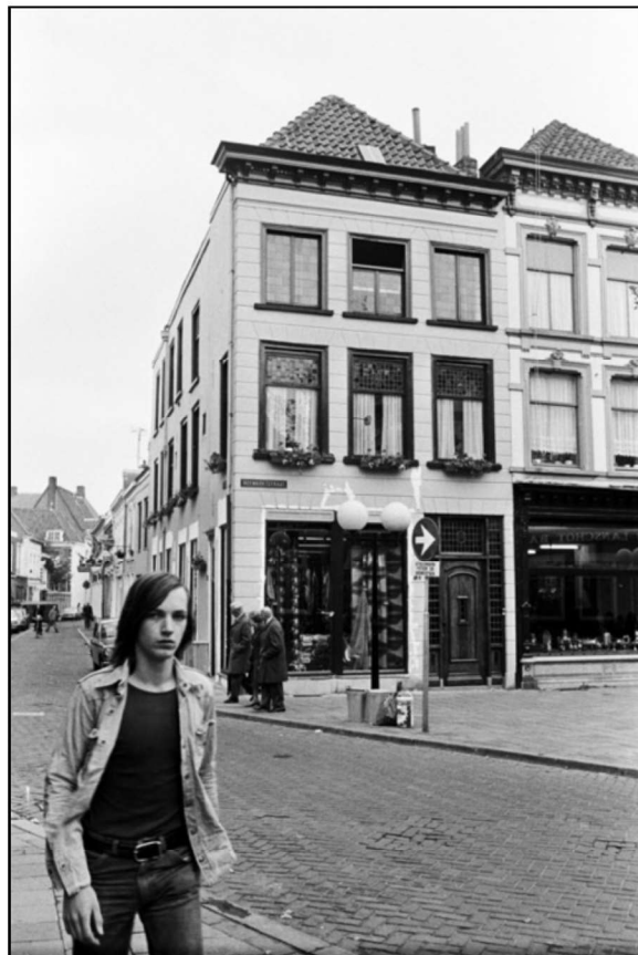
Afb 10 B: In 1975 was het pand opgeknapt, althans de voorgevel. Er was een genuanceerde kleurstelling op aangebracht. [Stadsarchief Breda, Johan van Gurp]
