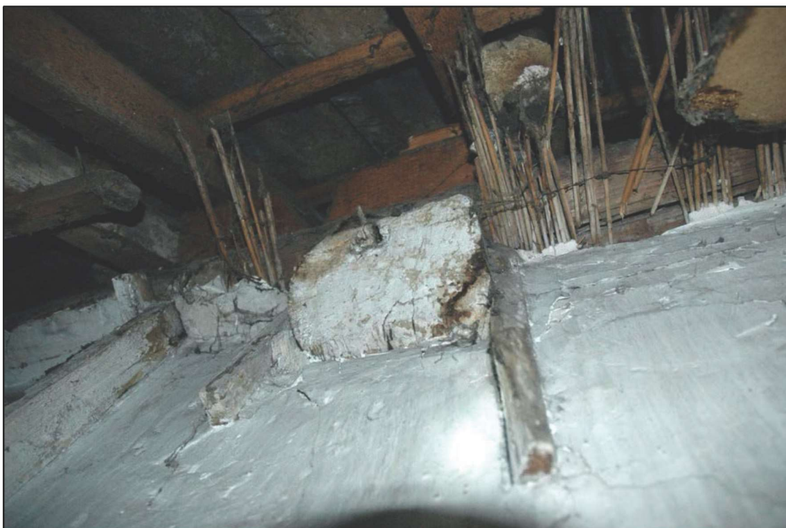
Afb. 53: Balkkop als uiteinde aan de linkerkant van de onderste dekbalk van het derde spant. De foto is omhoog genomen in de licht-/ luchtschacht. Hier had nog een spantbeen tevoorschijn moeten komen, maar dat is vervangen door een muur.
