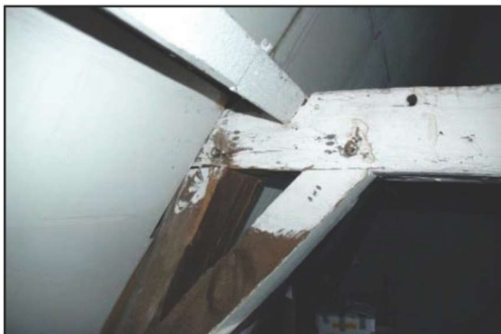
Afb. 59 [LO]: Het tweede spant geteld vanaf de voorgevel heeft het telmerk 3, rechts gehakt met de bijtel, links (op deze foto) gegutst.
