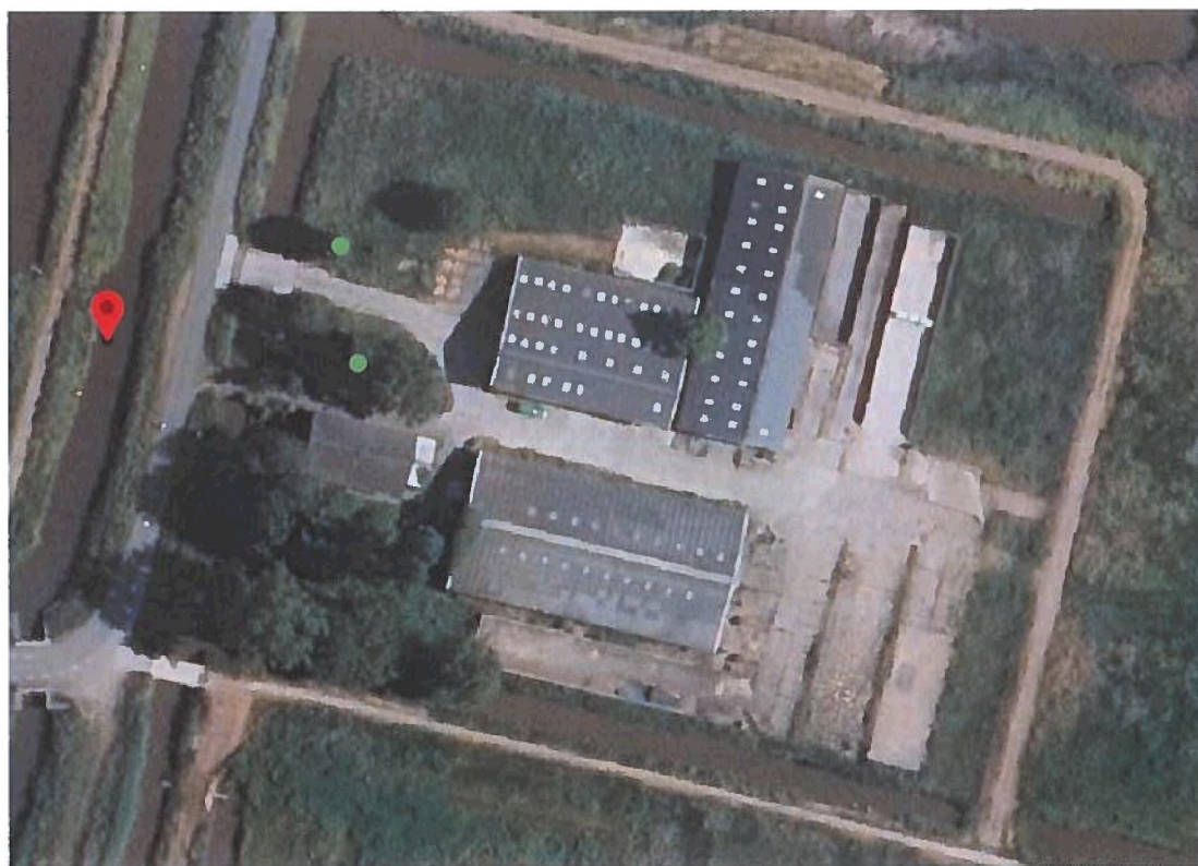
Figuur 4: Alternatieve verblijfplaatsen voor huismus in de vorm van 2 huismuskasten Middenweg BP 6 te Amstelveen.
