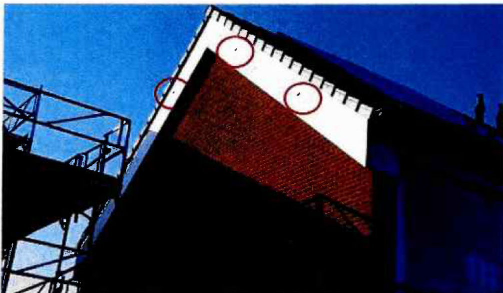
Figuur 12.12. Invliegopeningen van de ingebouwde gierzwaluwkasten, de vierde invliegopening is niet zichtbaar op de foto. Voorbeeld van een daklijst bij complex 1140.
