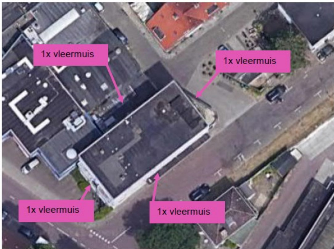
Figuur 1. Tijdelijke mitigatie voor vleermuizen aan de Nieuwe Kade 14.
