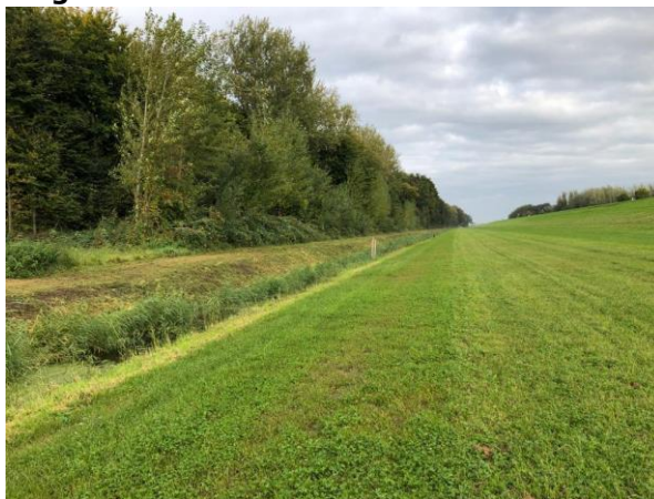
Figuur 6 Versterkte Drontermeerdijk wordt al mooi groen.
