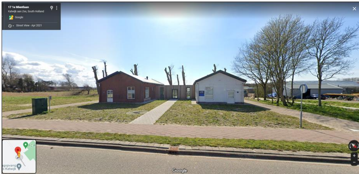
Vooraanzicht bebouwing 1 e Mientlaan 17 (bron: Google Maps).
