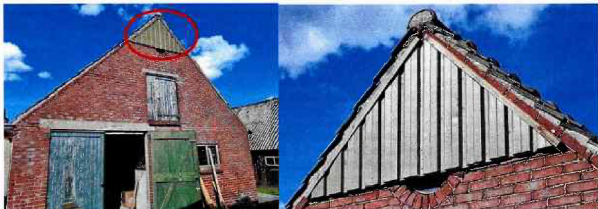
Figuur 10; Tijdelijk verblijf op te renoveren veeschuur
