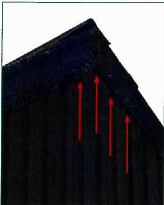
Afbeelding 3.6: Zuidelijke gevel van de lange schuur. Hier kruipen de grootoorvleermuizen hun verblijfplaats vanaf buiten naar binnen. Ondanks de relatief gladde damwandplaten blijken de vloermuizen voldoende grip te hebben.
