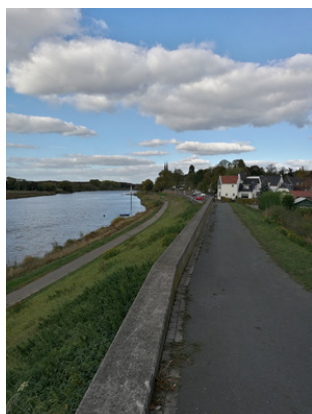
Afbeelding 5. Dijk aan de Maashoek
