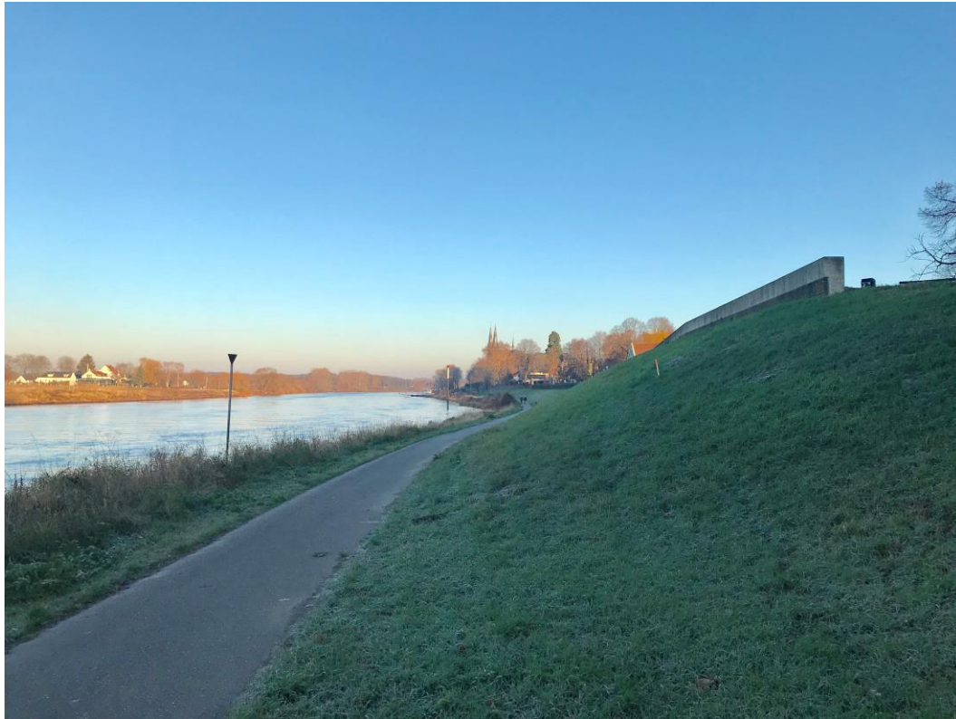
Figuur 15. Foto van de steilrand en kering vanaf het zuidelijkste punt van het plangebied (foto IBM, 2018).
