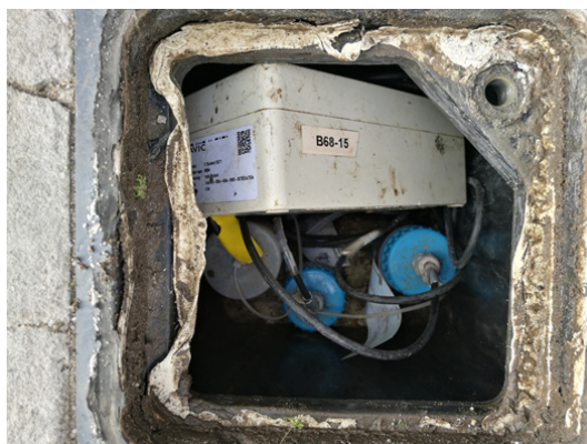
Afbeelding 6. Peilbuis aan Maashoek
