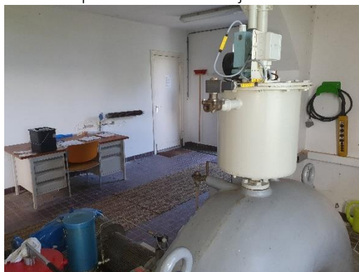
Foto 4: Impressie van de binnenzijde van de machinekamer
