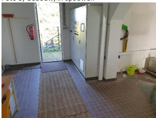
Foto 5: Gebouw, onder vloerafwerkingen
