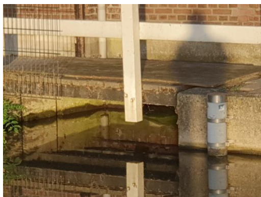
Foto 2: Impressie van de voorzijde wateruitlaat
