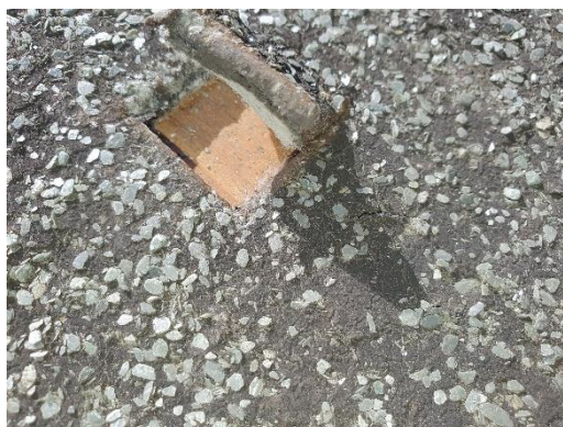
Foto 2: Gebouw, in spouwen
