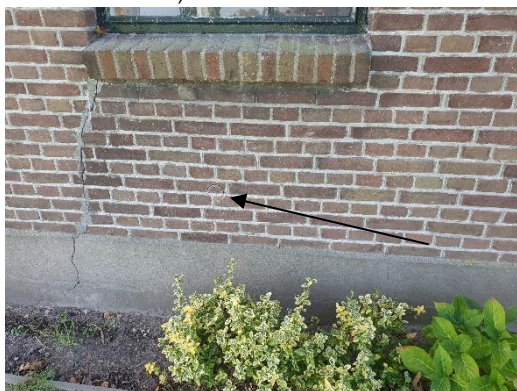
Foto 3: Gebouw, in spouwen
