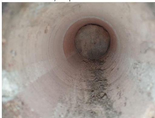
Foto 4: Gebouw, in spouwen
