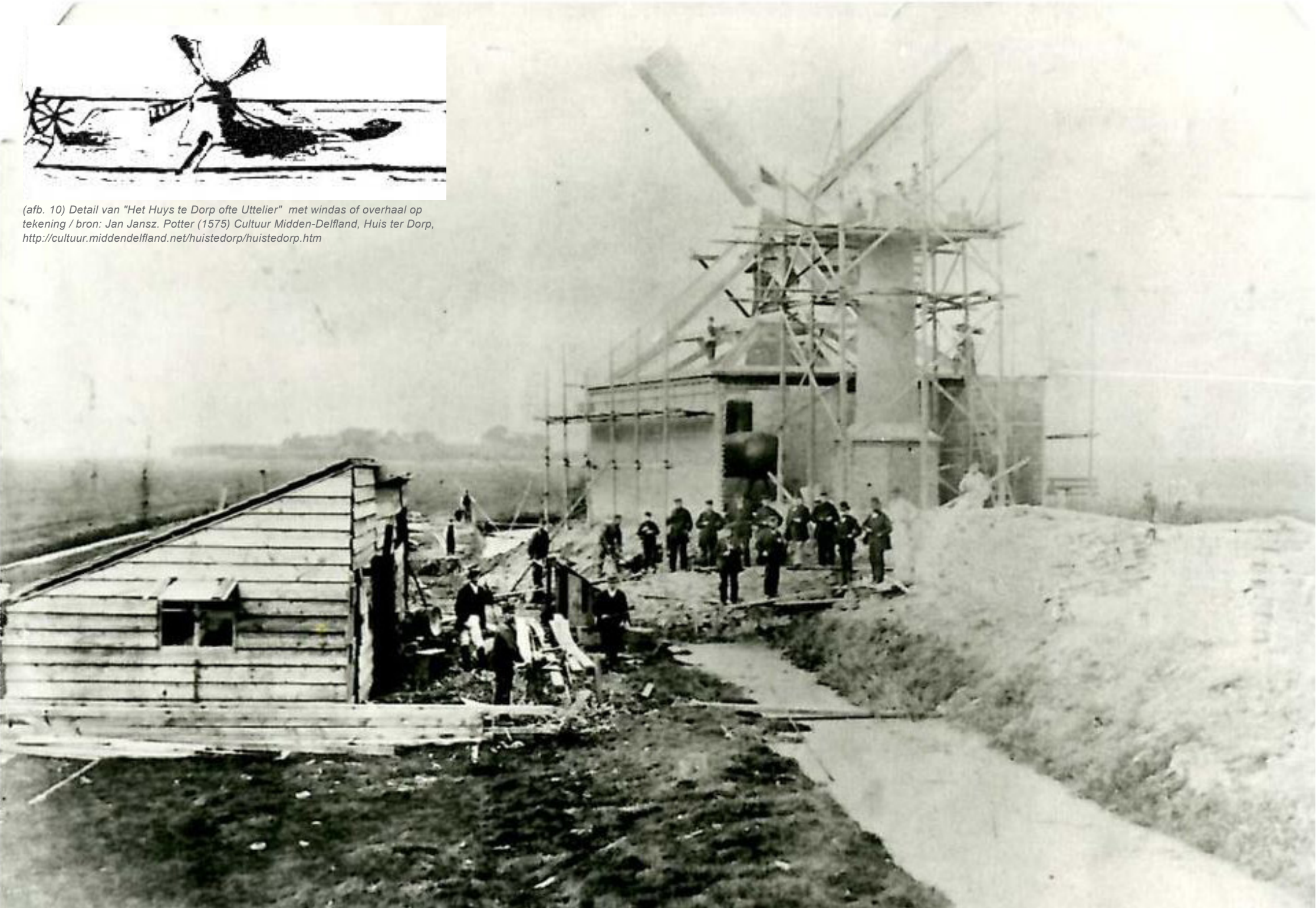
(afb. 11) Bouw van het gemaal in 1876, de Grote Dorpmolen is in de achtergrond aanwezig. | bron: Cultuur Midden-Delfland, Twee gezichten van... Nr. 47: Het gemaal van de Dorppolder, http://tweegezichten.middendelfland.net/047dorppoldergemaal.htm
