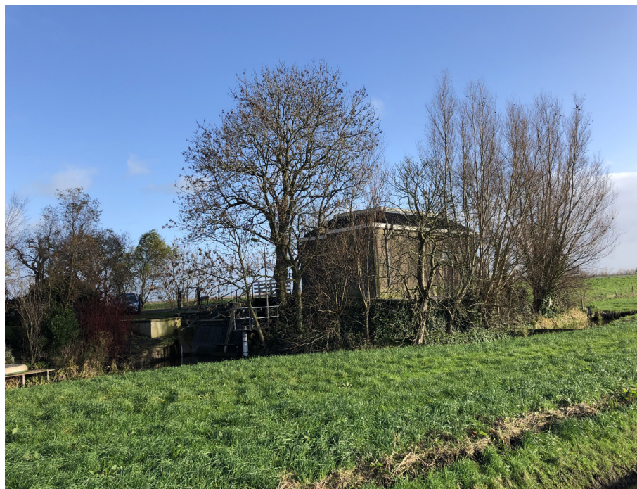
(afb. 50) zicht op noordwest- en zuidwestgevel (foto TAK architecten, 01 december 2020)
