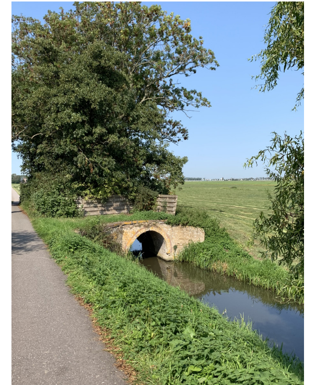
(afb. 49) heul of overbrugging sloot (foto TAK architecten, 01 december 2020)
