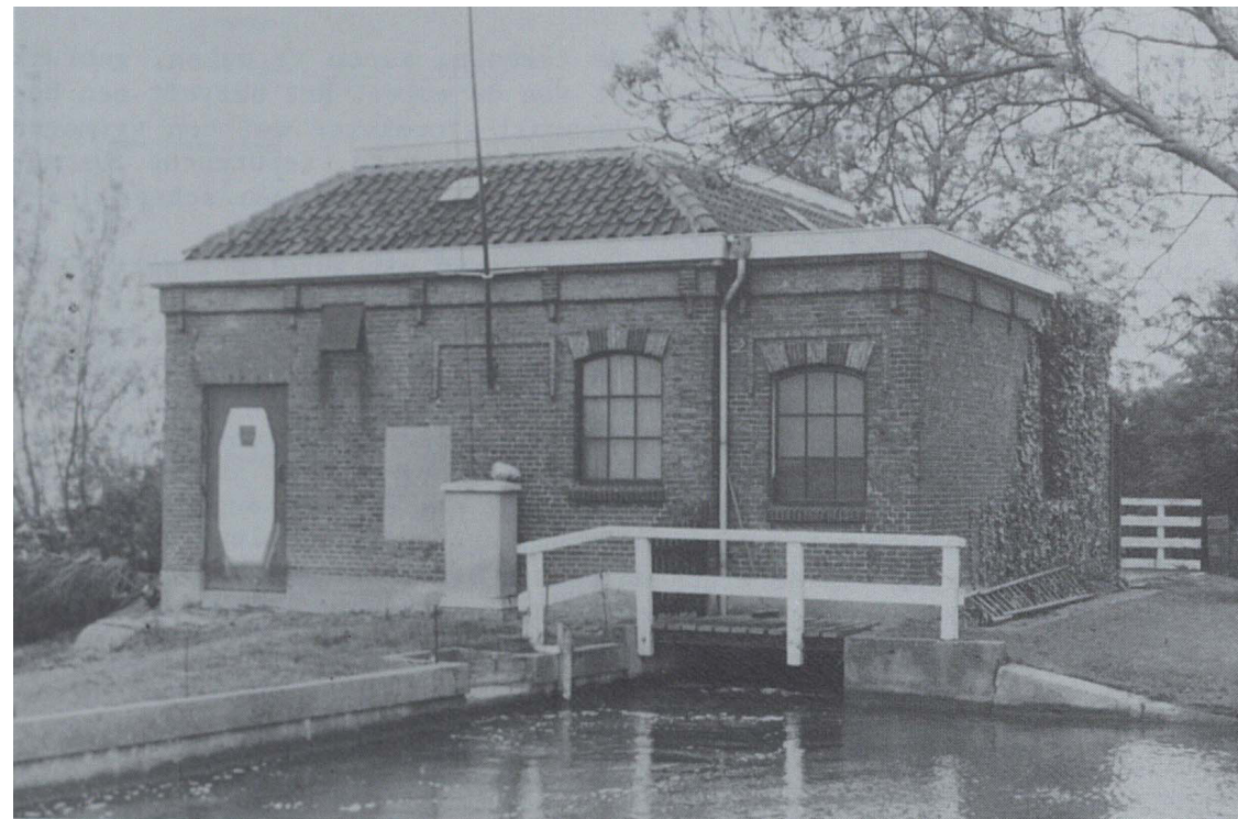
(afb. 31) het gemaalgebouw in ca. 1985, de gootlijsten zijn hier al vervangen. / bron: Ottevanger, G. (1985) Molens, gemalen en andere waterstaatkundige elementen in Midden-Delfland, Den Haag: Provinciale Waterstaat Zuid-Holland
