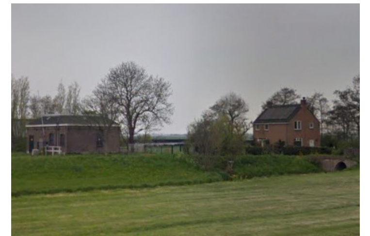
(afb. 42) Het ensemble van gemaalgebouw, de machinistenwoning en heul in de huidige situatie / foto: www.googlemaps.nl (2021)
