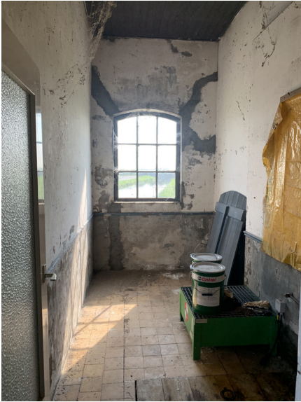
(afb. 37) gele tegels uit 1919, bedekt door tapijt in ruimte 01.a / foto: TAK architecten (2021)
