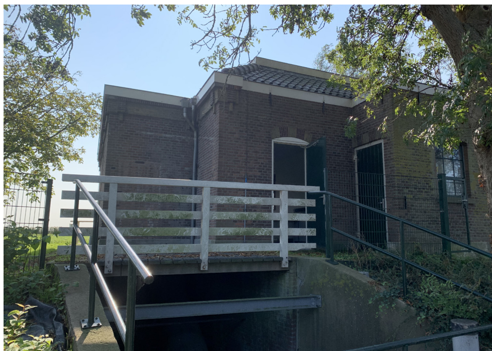
(afb. 56) noordwestgevel (foto TAK architecten, 01 december 2020)
