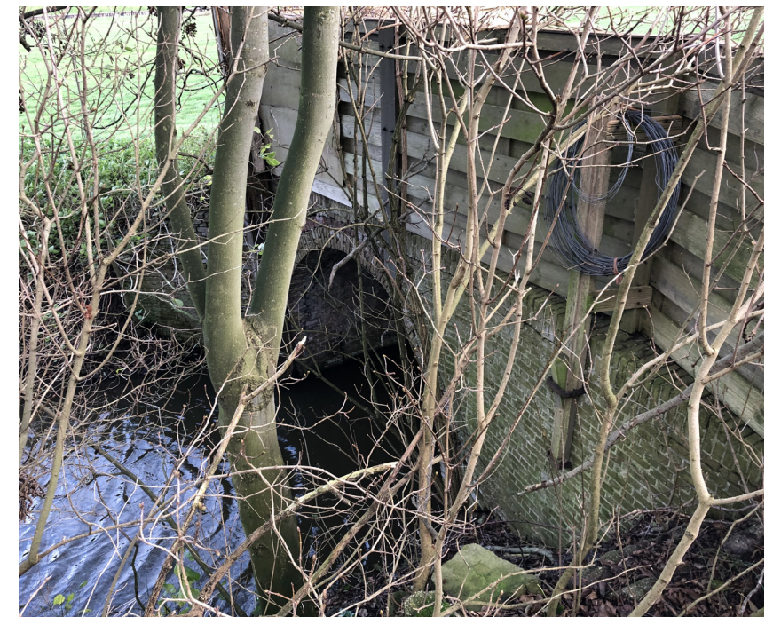
(afb. 52) heul of overbrugging sloot (foto TAK architecten, 01 december 2020)
