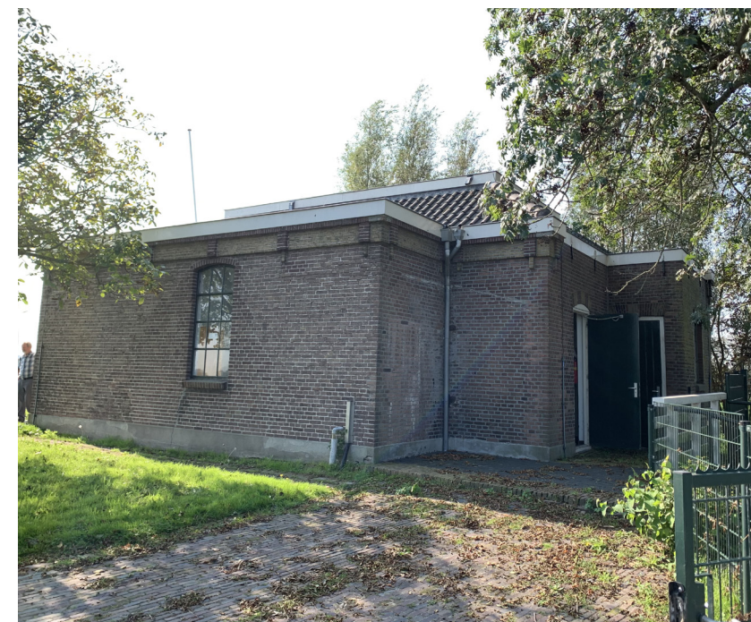
(afb. 58) noordoostgevel (foto's TAK architecten, 01 december 2020)
