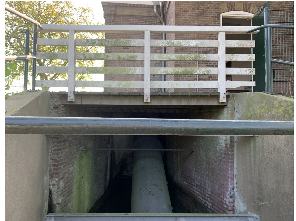
(afb. 63) gemaal aan de inlaatzijde, houten delen over de innlaat (foto TAK architecten, september 2020)
