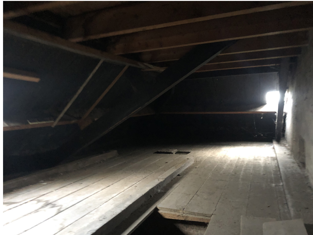
(afb. 72) zolder boven machinekamer (foto TAK architecten, 01 december 2020)
