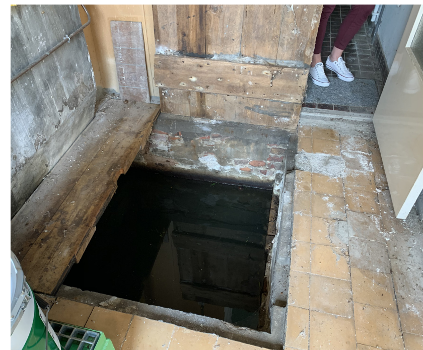
(afb. 67) luik naar schepdang (foto's TAK architecten, 01 december 2020)
