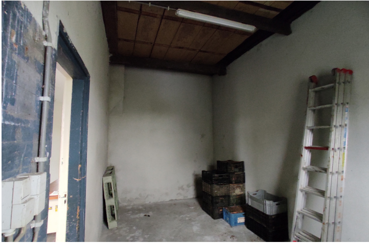
(afb. 34) de berging (ruimte 0.2) met betonnen vloer / foto: TAK architecten (2021)
