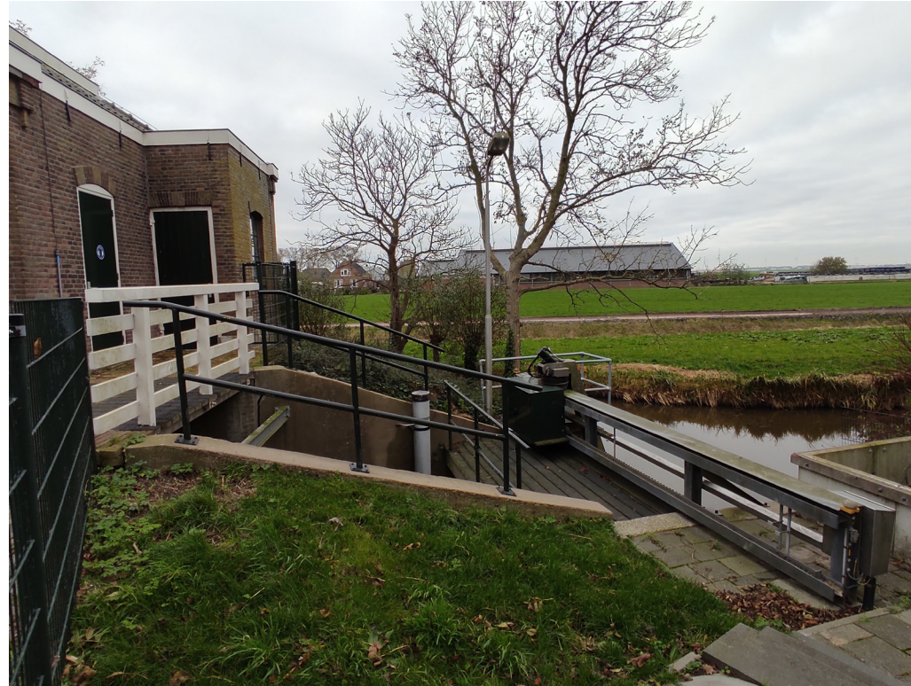
(afb. 61) overzicht inlaatzijde | foto: TAK architecten (2021)
