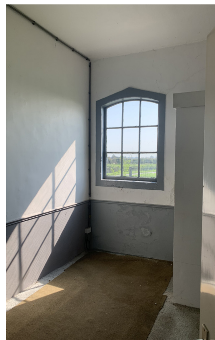
(afb. 69) ruimte met toilet (foto's TAK architecten, 01 december 2020)
