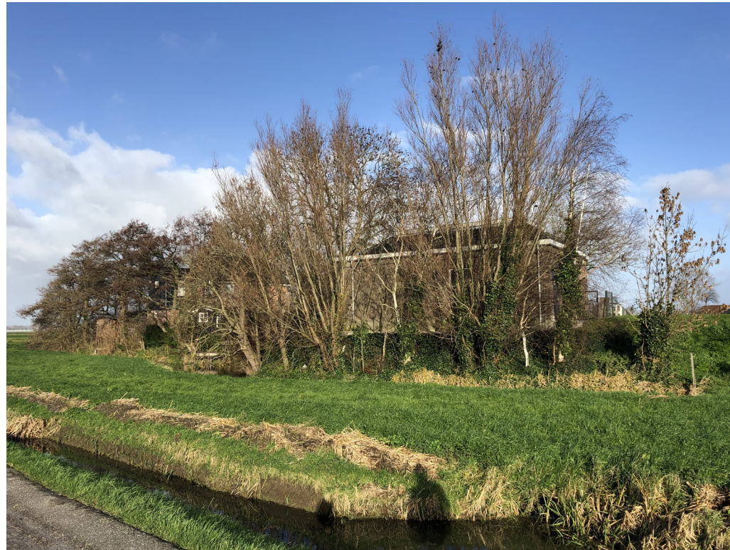
(afb. 48) zicht op zuidwestgevel (foto TAK architecten, 01 december 2020)
