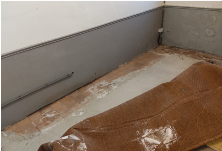
(afb. 35) gele tegels uit 1919, bedekt door tapijt in ruimte 01.b / foto: TAK architecten (2021)
