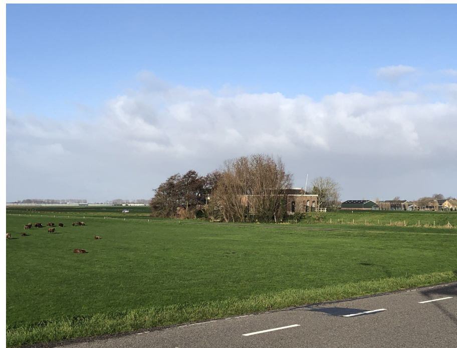
(afb. 51) zicht op zuidwestgevel (foto TAK architecten, 01 december 2020)
