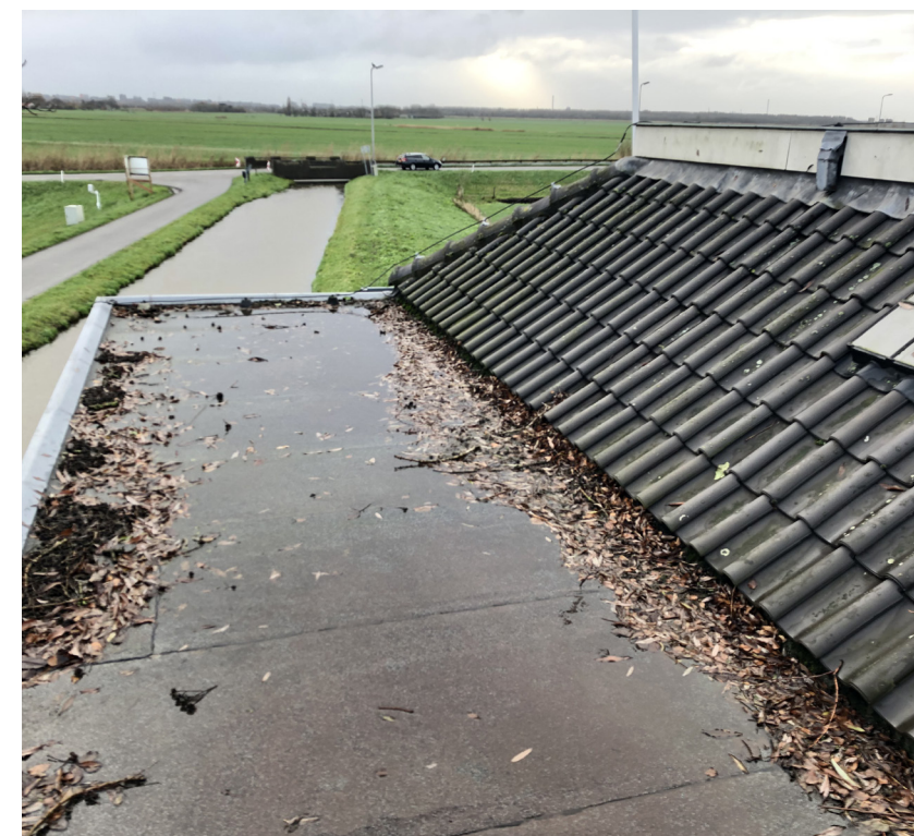
(afb. 57) dak (foto's TAK architecten, 01 december 2020)
