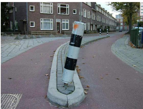
Figuur 4.9 scheefstand paal op niveau C. Wordt getolereerd in de voormalige hotspots binnen het scenario Dinkelland Groen. Bron: CROW.nl
