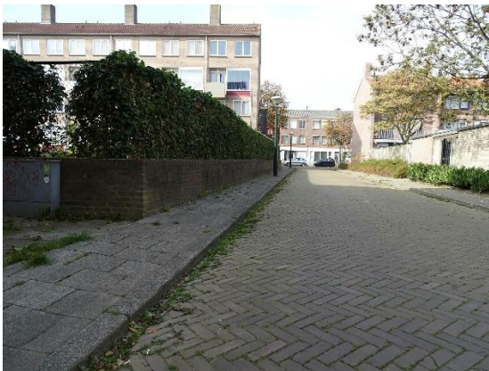
Figuur 4.7 onkruid in de goten op niveau C. wordt getolereerd in voormalig verblijfsgebied binnen het scenario Dinkelland Groen. Bron: CROW.nl
