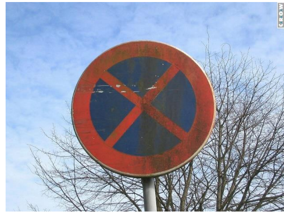
Figuur 4.8 bevuilding op een bord op niveau C. Wordt getolereerd binnen de voormalige hotspots binnen het scenario Dinkelland Groen. Bron: CROW.nl
