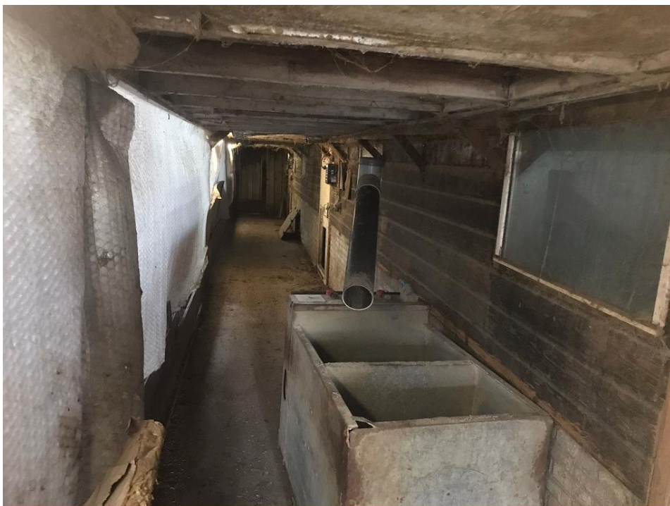
Centrale ruimte tussen de te slopen stallen
