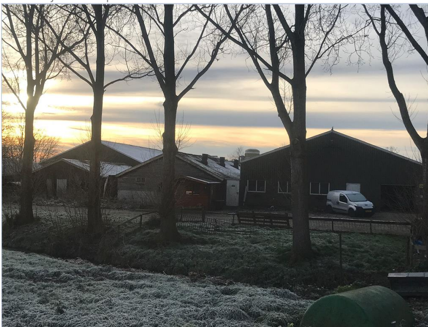
Voorzijde aanzicht van de te slopen stallen.
