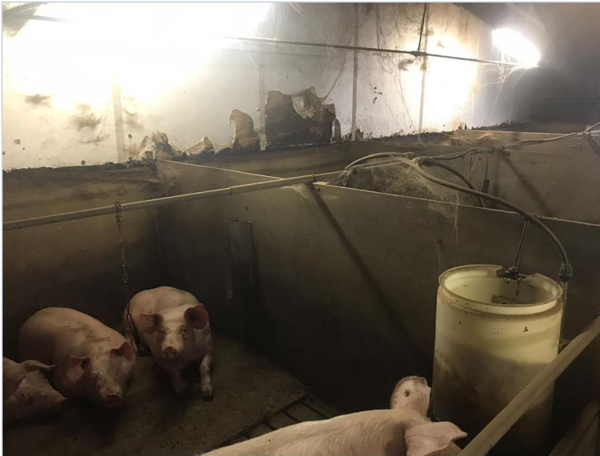
Binnenzijde te slopen varkensstal
