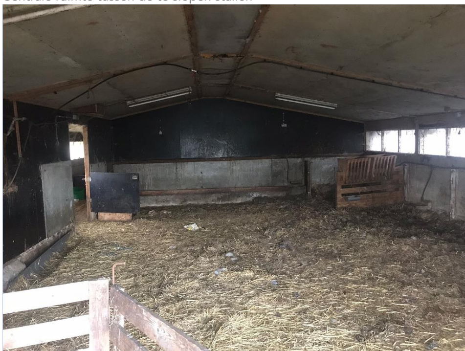
Te slopen jongvee stalruimte
