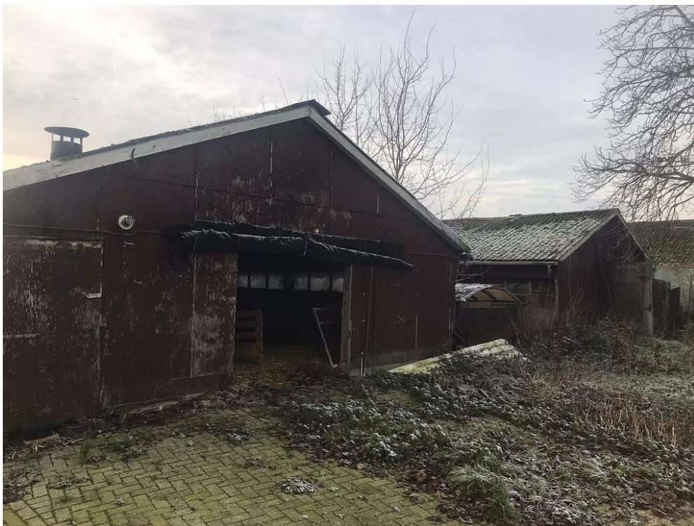
Voorzijde te slopen jongvee stalruimte
