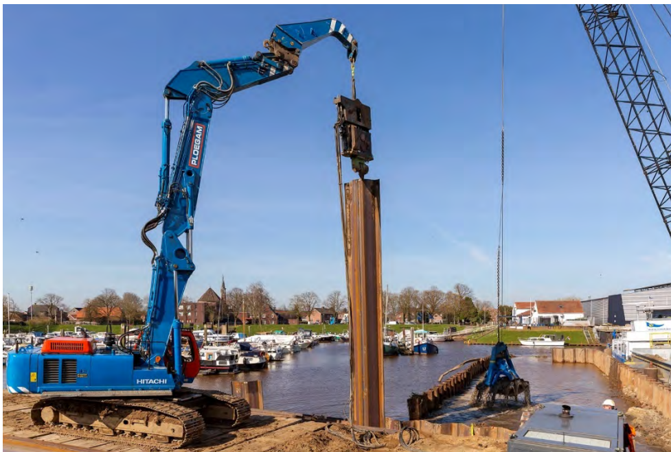
Figuur 2.61 Impressie van het aanbrengen van damwanden
