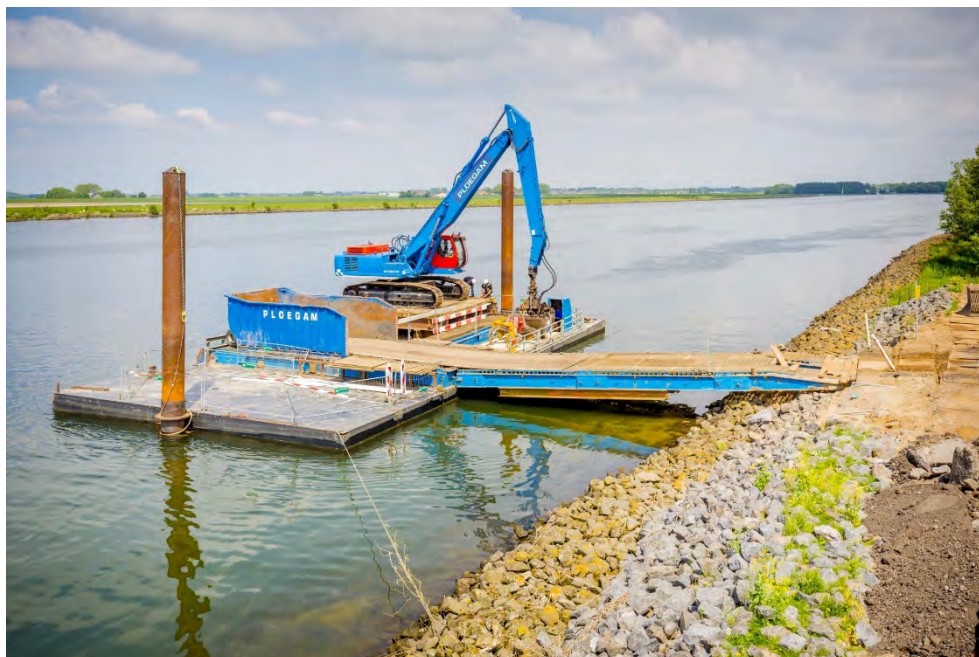
Figuur 2.64 Impressie van een tijdelijke aanlegplaats
