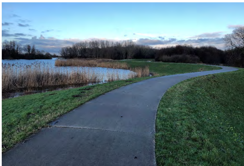
Foto 2.49 Waterkering langs de Westerveldse kolk
