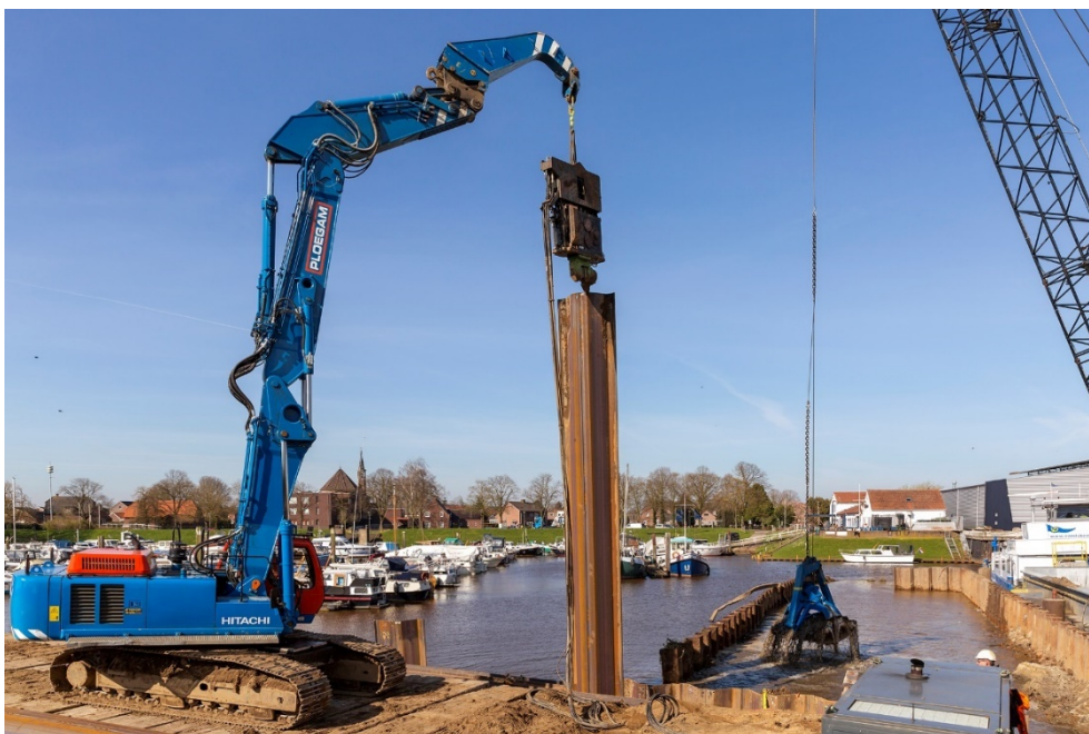
Figuur 2.19 Impressie van het aanbrengen van damwanden
