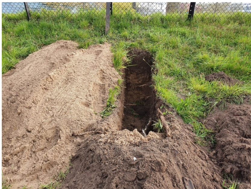
Figuur 2.15 Impressie van een proefsleuf op het bedrijventerrein van Leeman te Zwolle
