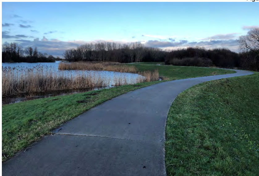
Foto 2.49 Waterkering langs de Westerveldse kolk
