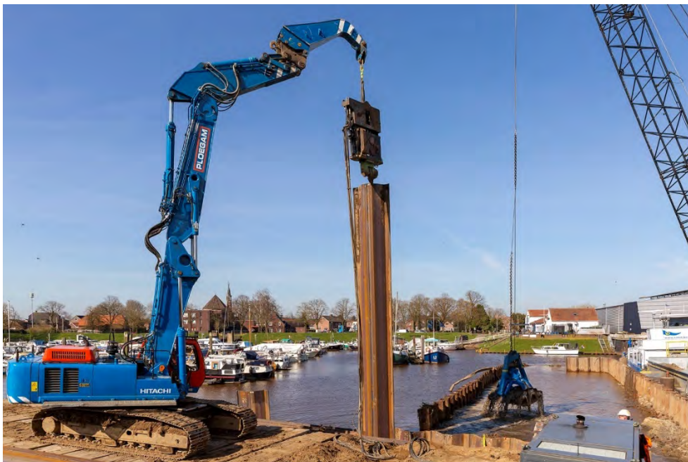
Figuur 2.61 Impressie van het aanbrengen van damwanden
