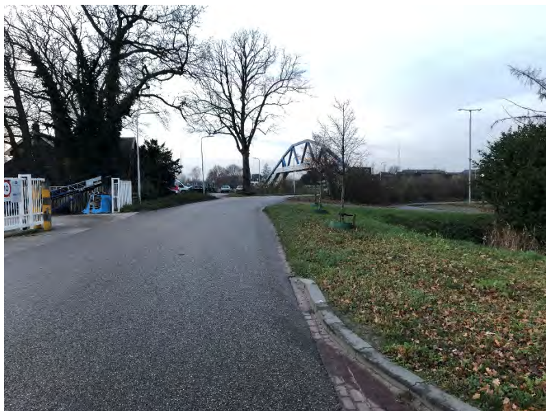
Foto 2.17 Verholen waterkering Gasthuisdijk
